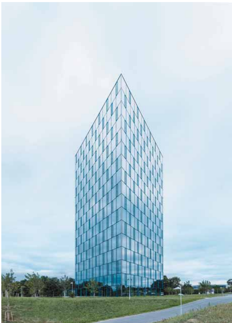
Передовой проект: оболочка здания нового Центра Автоматизации от компании Festo полностью состоит из т.н. «климат-активного» стекла, придавая зданию современный и представительный вид. Фото: Festo
