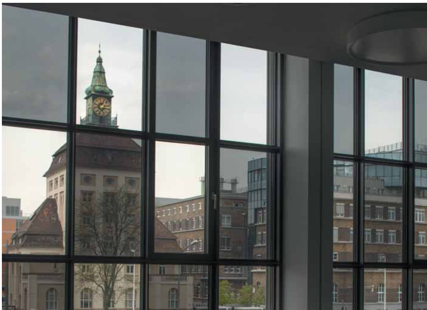
Новые краски: оконные разработки центра инноваций компании Merck из немецкого Дармштадта произведены на основе жидких кристаллов, которые за секунды переключаются с освещения на затемнение и наоборот. Фото: Merck
