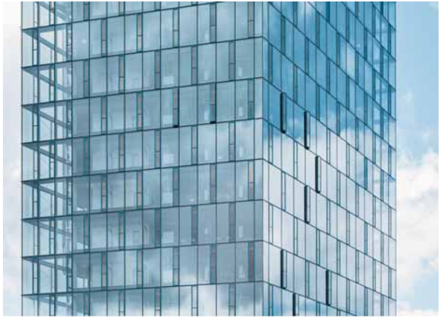
Энергоэффективность: стеклянные фасады нового Центра Автоматизации производства компании Festo построены по принципу вентилируемых фасадов, а электрохромные стекла автоматически адаптируются к изменению уровня освещенности. Фото: Festo
