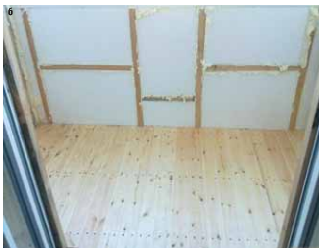
Рис. 1. Монтаж теплоизоляционных плит: а – на основе минеральной ваты; б – из вспененного полистирола
