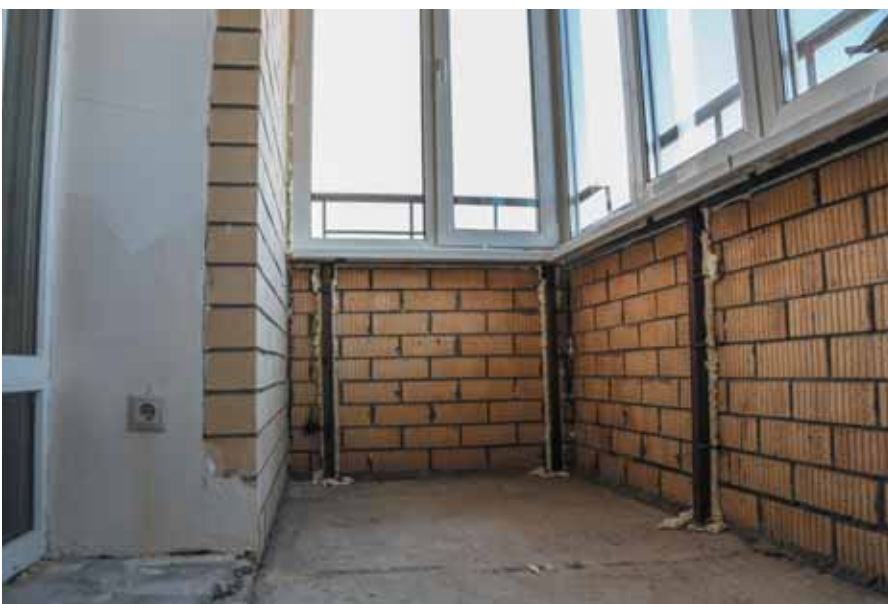
Рис. 3. Помещение перед началом работ по утеплению
