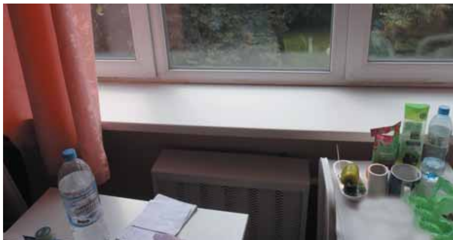
Батарея закрыта подоконником и декоративным экраном
