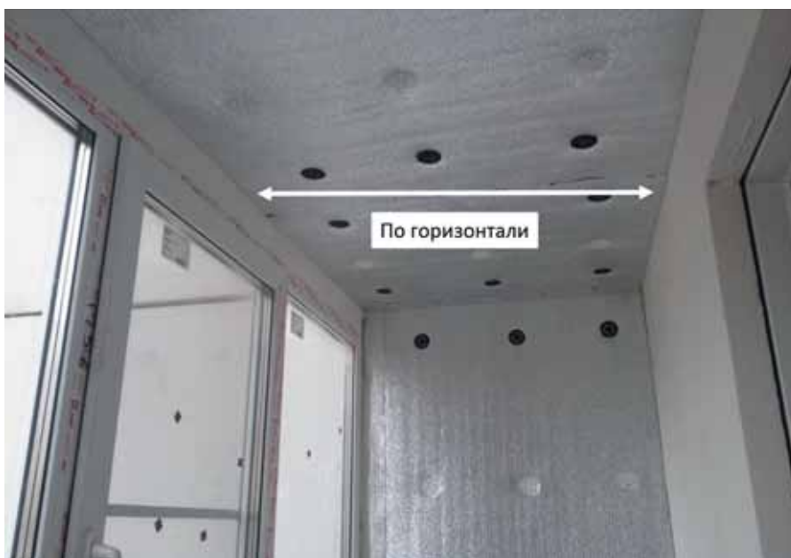
Рис. 8. Утепление потолка
