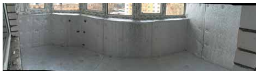
Рис. 10. Утепленная лоджия перед облицовкой
