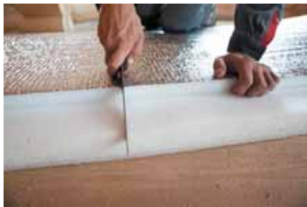
Рис. 4. Раскрой и монтаж утеплителя
