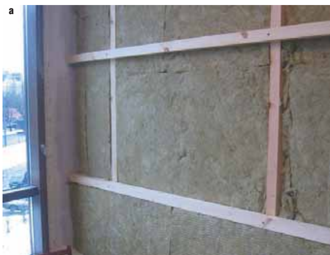
Рис. 1. Монтаж теплоизоляционных плит: а – на основе минеральной ваты; б – из вспененного полистирола
