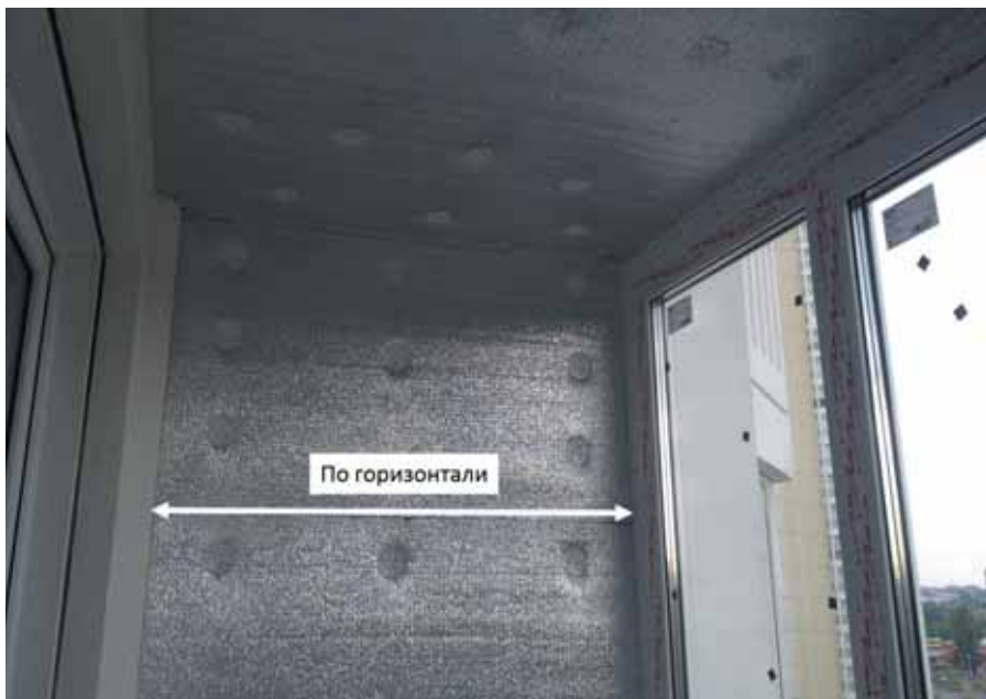
Рис. 6. Утепление боковых стен
