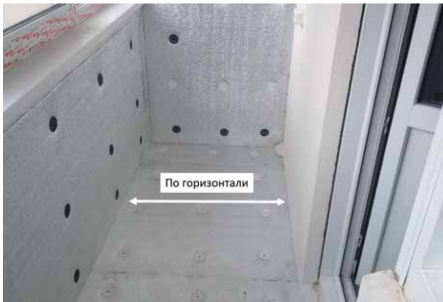
Рис. 9. Утепление пола
