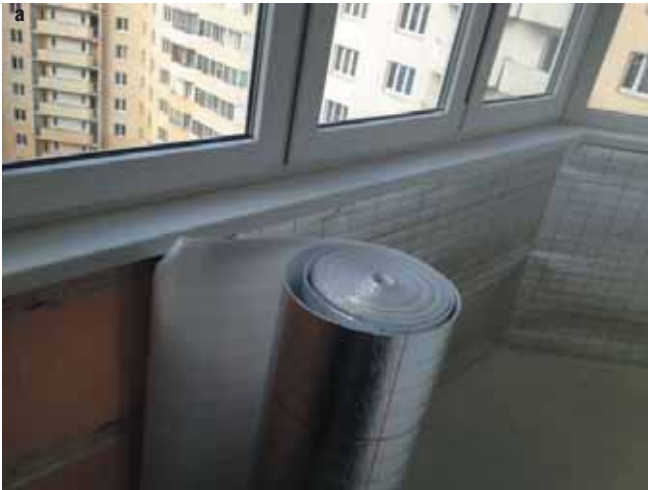
Рис. 2. Монтаж финишной пароизоляции: а – рулонный фольгированный пенополиэтилен; б – полиэтиленовая пленка
