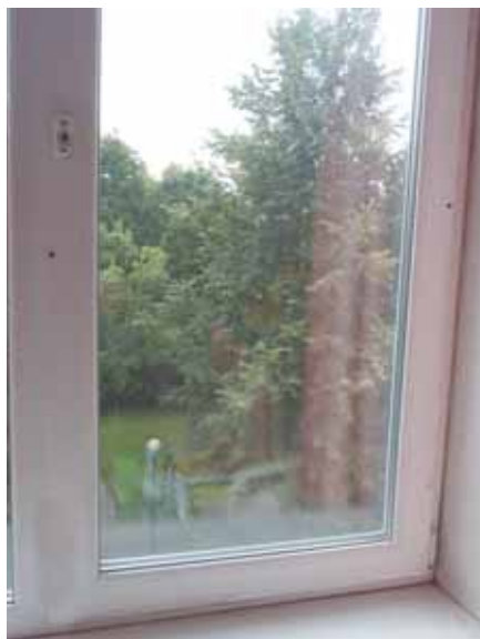
Сломанная створка заглушена саморезами
