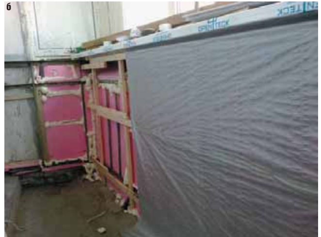
Рис. 2. Монтаж финишной пароизоляции: а – рулонный фольгированный пенополиэтилен; б – полиэтиленовая пленка
