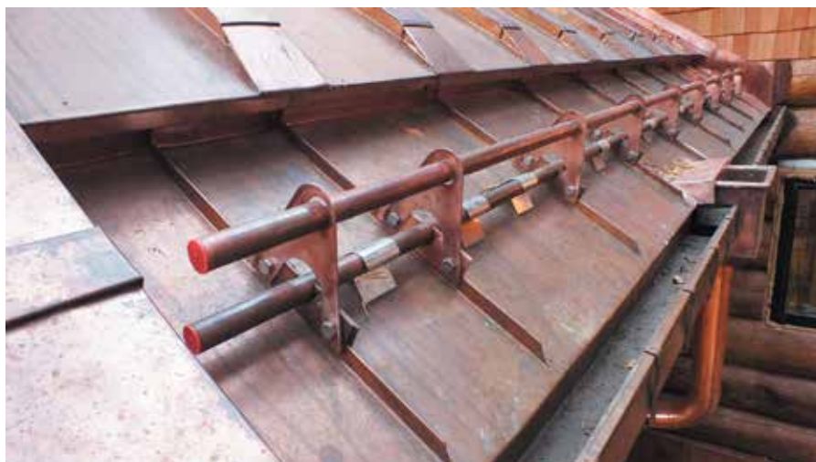
Двухтрубчатая система снегозадержания линейного типа CUPPRO. Водосборная воронка квадратного типа и круглые трубы AQUASYSTEM. Распорные рассекатели льда из нержавеющей стали. Красная рулонная медь ГЗОЦМ.
