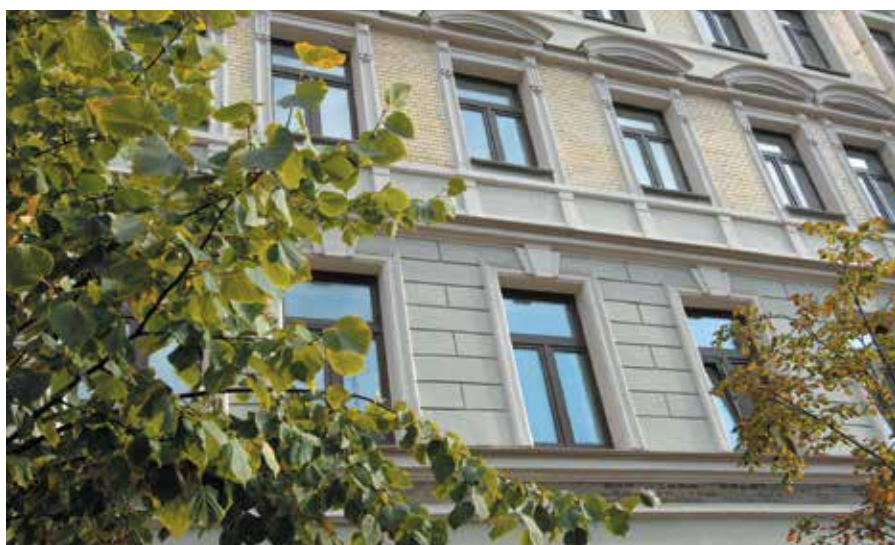
Здание в историческом центре г. С-Петербурга. Остекление окнами из цветного ламинированного ПВХ профиля IVAPER
