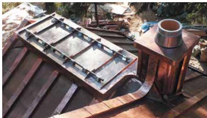
Трудоемкий участок работы мастера с винтажным исполнением: зона пешеходного трапа плоского конька с сопряжением дымоходной трубы и рассекающий ее поалам линией фронтоного свеса с декоративным обрамлением.
