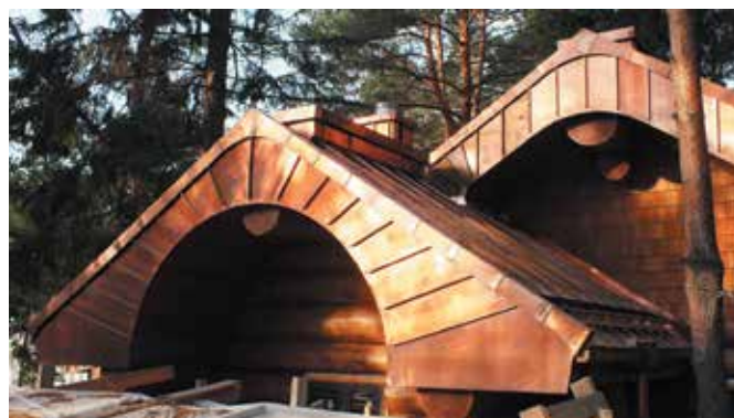
Двухконтурный вертикальный уровень фронтовых свесов с радиусным и эллипсным выполнением: нижний уровень – веерная укладка фальцевых картин с шагом 318 мм (R=1610); верхний уровень – вертикальные картины с шагом 370 мм. Техника исполнения – фасадный угловой фальц 25 мм с полукруглыми удлиненными мысиками и элементами на внешней рейке.
