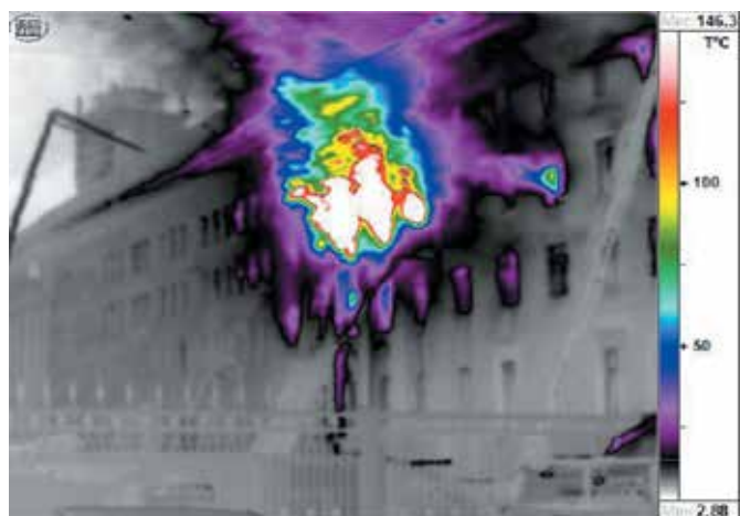
Обнаружение и обследование очагов пожаров
