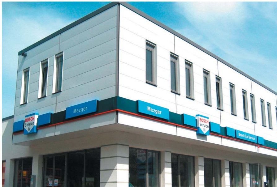
Сервисный центр Bosch (Дрезден, Германия) Архитекторы: Архитектурное бюро Мюллер + Шверда, Дрезден
