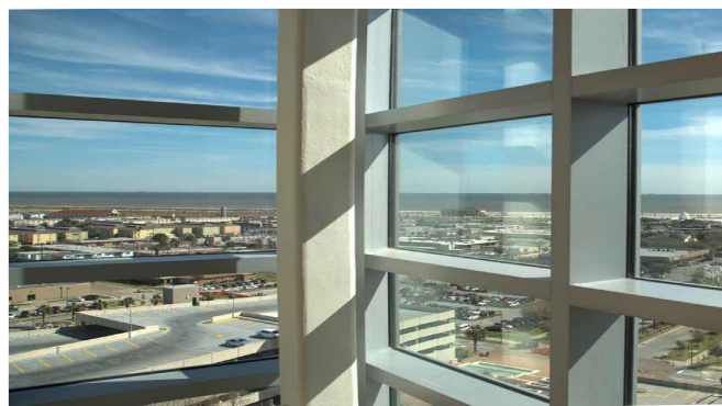
Фасад YKK с силиконовым остеклением с двумя слоями SentryGlas толщиной 2,3 мм соответствует требованиям к защите от ураганов уровня «Е».
