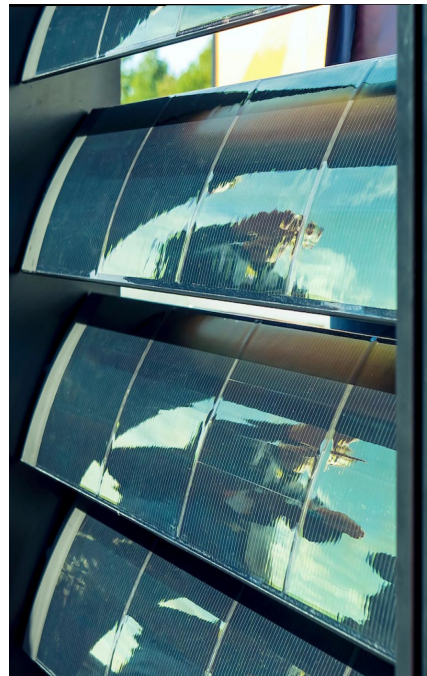
Благодаря постоянно обновляемым данным, ламели автоматически регулируются оптимальным образом к положению солнца.
