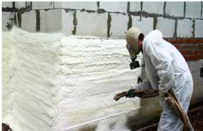
Рис. 7. Напыление ППУ на цоколь дома
