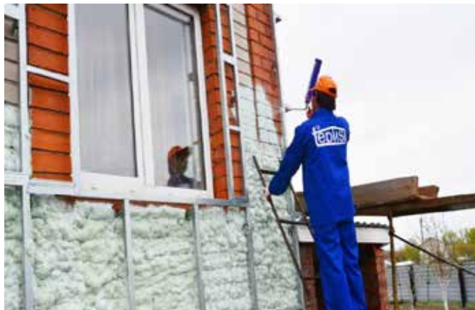
Рис. 8. Утепление с помощью напыляемого ППУ «Теплист»
