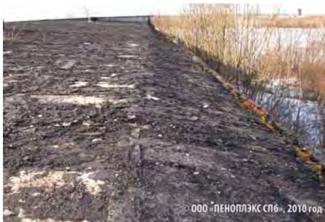
Рис. 5. Промышленное здание в г. Кириши. До ремонта кровли
