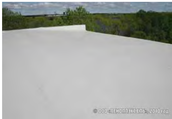
Рис. 6. Промышленное здание в г. Кириши. После ремонта кровли с ПЛАСТФОИЛ®
