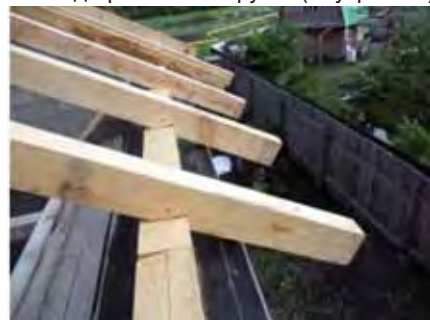
Устройство простого карнизного свеса 600 мм
