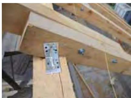
Промежуточное крепление стропил и стягивание их между собой внахлест
