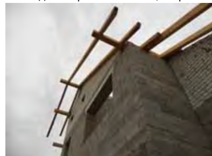
Устройство карниза 600 мм по фронтому
