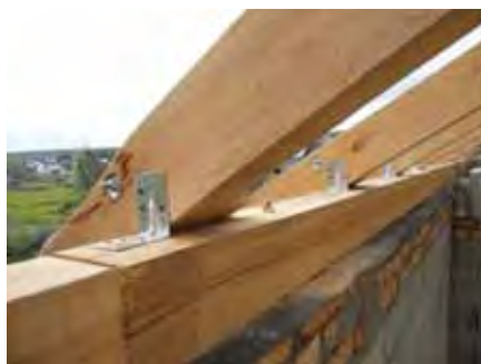
Крепление стропил к подстропильному брусу
