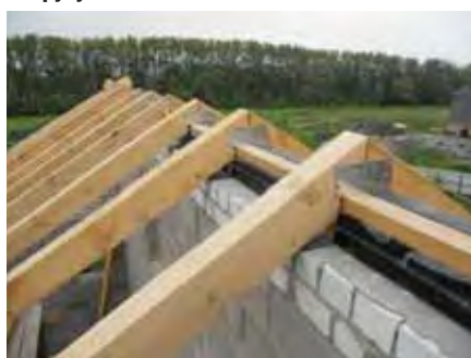
Крепление стропил к коньковому брусу
