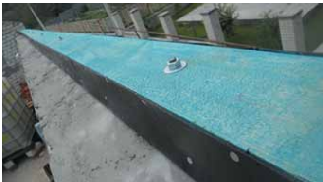
Рис. 2. Крепление мауэрлата на закладных шпильках с пластинами, которые были закреплены внутри кирпичной кладки парапета
