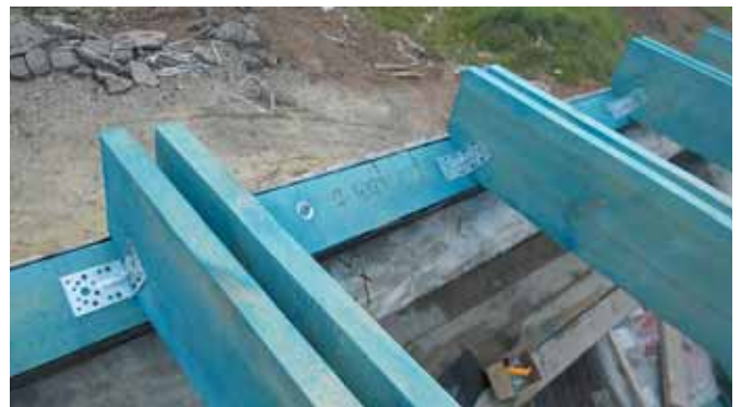
Рис. 11. Узел опирания составных стропильных ног на мауэрлат
