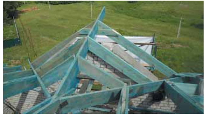
Рис. 9. Общий вид конькового прогона в сопряжении с наклонными ногами
