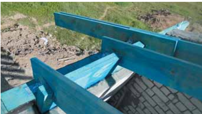
Рис. 7. Фронтальный прогон из двух досок сечением 250х40 мм
