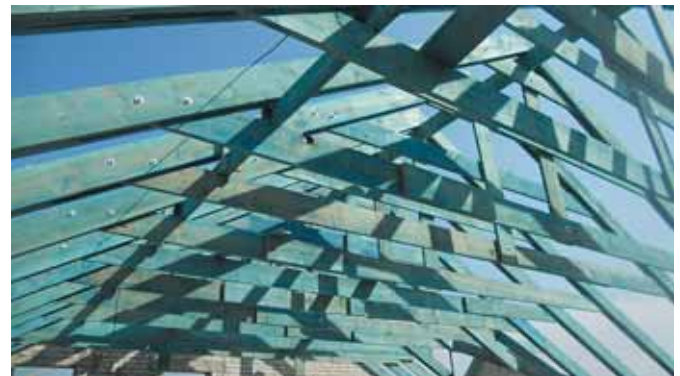
Рис. 10. Общий вид наклонных одинарных ног и конькового прогона из досок сечением 250х40 мм
