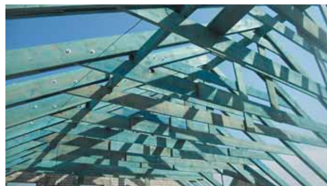
Рис. 10. Общий вид наклонных одинарных ног и конькового прогона из досок сечением 250х40 мм
