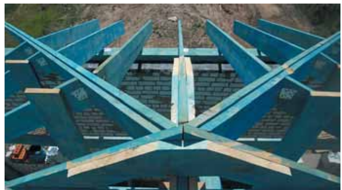
Рис. 4. Узел конькового прогона на вальме – одинарная стропильная нога с двумя накладными элементами (вид сверху)
