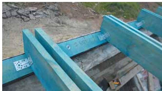
Рис. 11. Узел опирания составных стропильных ног на мауэрлат
