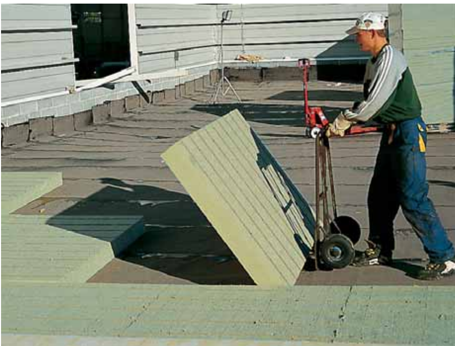
Укладка теплоизоляционных плит с канавками PAROC ROS 40g
