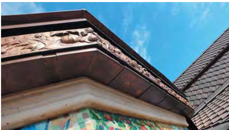
Угловой фрагмент карнизной части купола на фоне мозаики ручной работы (цветочный ирис) и белого бетона после зимней окисации приобрел благородную матовую поверхность с гранатно – изумрудным оттенком. Ручное изготовление мозаичного панно выполнила студия Мозаичный мир.
