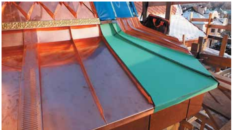
Общий вид установленной лебединой лапки в виде фальцевой картины в технике двойного стоячего фальца с применением полукруглых конвертов и подрезкой полукруглых мысиков на карнизных свесах
