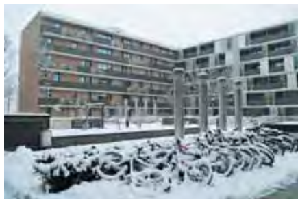
Утепленные пенополистиролом домов в Австрии
