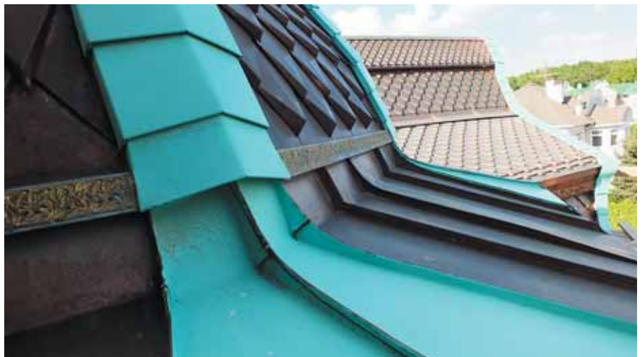
Общий вид цветового решения купола – штучная черепица из красной меди, которая за зимний период времени получила окисленный цвет, хребты из патины и карнизные орнаменты из латуни. В декабре 2015 года процесс оксидации красной меди только начался и достиг своего апогея в феврале 2016 года с равномерным темным оттенком. Технологический процесс изготовления штучной черепицы был таковым – на синтетической мембране маркером была нанесена разметка в виде линий по высоте и ширине каждой черепицы. Затем с использованием плотной бумаги снимались шаблоны каждого ряда черепицы. Это повысило точность монтажа черепицы и было связано с небольшими погрешностями в плоскостях скатов и примыкающих деревянных накладных хребтов. Изготовление черепицы производилось на сегментном станке «Эдельвейс» производства России.
