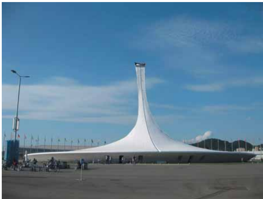
«Чаша Олимпийского огня», Сочи, «Архитектурное бюро «Ардепо», проект ООО «Кубань Универсал Проект», генеральный подрядчик «Строй Интернейшнл» (Краснодар)
