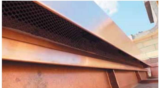
(д) Вид снизу – декоративная планка, медная москитная сетка и фальш-планка
