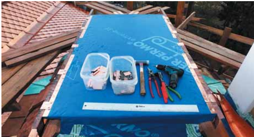
Укладка синтетической трехслойной мембраны Klover Extreme SK играет важную роль в качестве разделительного слоя между деревом и металлом – перед укладкой фальцевых картин на пологом навершии
