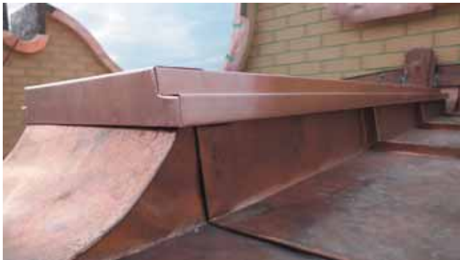
(б) Монтаж декоративных подконьковых планок ступенчатого типа
