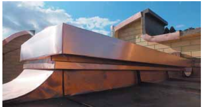
(е) Общий вид установленных планок на фоне фальцевых картин
