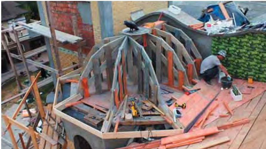
Возведение каркаса фермы велось строго по техническому заданию архитектора с соблюдением уклонов на всех гранях и установкой контрольных отметок высот
