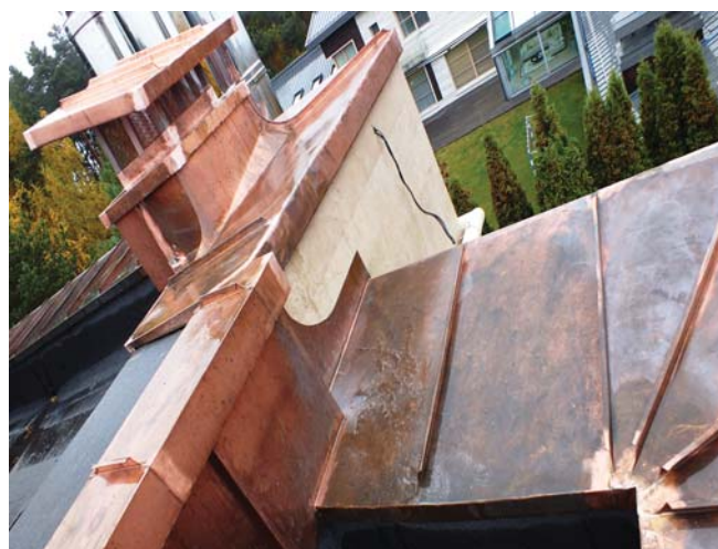
Рис. 13. Симбиоз выполнения различных узлов и деталей по защите каменного фасада с применением технологии углового фальца 25 мм и низкотемпературной пайки: картины парапетов, фасадных элементов, обрамление ограждений и вентиляционные трубы.
