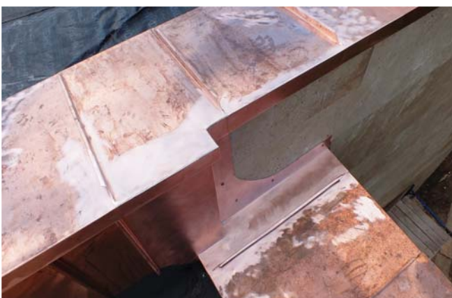
Рис. 6. Вид сверху на многоуровневую часть сопряжения двух парапетов обрамление которых выполнено фальцевыми картинами шириной 519 мм и замками в технике углового фальца высотой 25 мм с декоративными полукруглыми мысыками.
