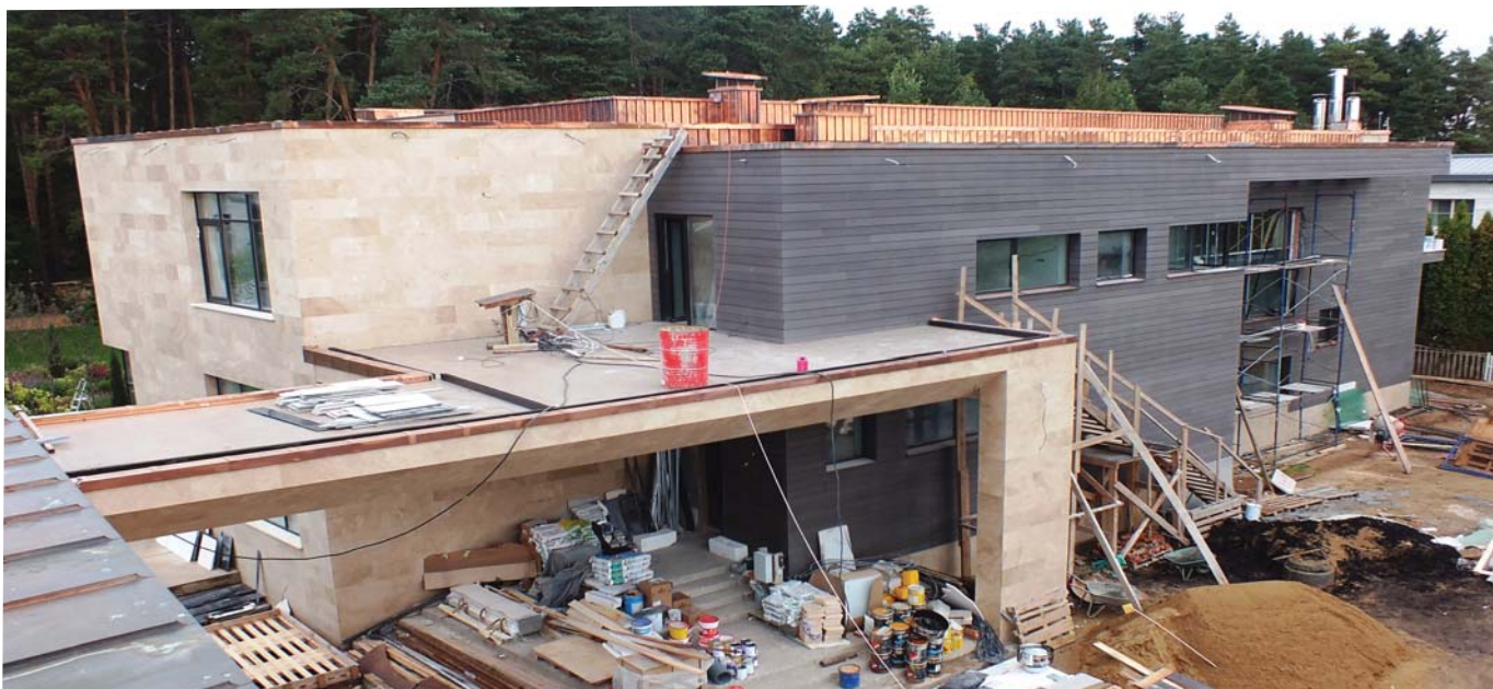
Рис. 2. Видовой кадр главного фасада жилого дома с остекленным балконом-террасой. Система защиты деталей фасадов здания (парапеты, отливы, ограждения) на задний из камня и высокоуглеродистых фасадных панелей. Высокотрудоемкая работа в технике Falzwork. Низкотемпературная пайка. Красная медь из Сибири.
