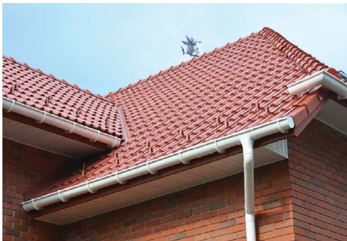
Рис. 8. Пример устройства водостоков
