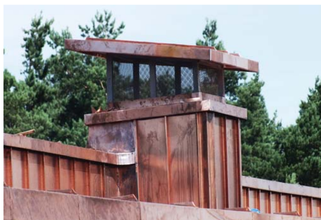
Рис. 11. Общий вид примыкания вентиляционной трубы к многоуровневым парапетам здания расположенных на плоской кровле жилого дома с медным высокотрудоемким обрамлением в технике фасадного углового фальца 25 мм и применением низкотемпературной пайки.
