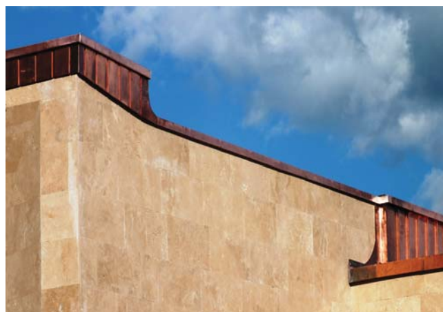
Рис. 8. Общий вид угловых парапетов дворового фасада в гибридной технике: слева – декоративные элементы вертикального типа на внутренней рейке; справа – вертикальные фальцевые картины объединенные общей верхней линией обрамления с отступом 40 мм от каменного фасада для его защиты от снежного покрова и атмосферных осадков.
