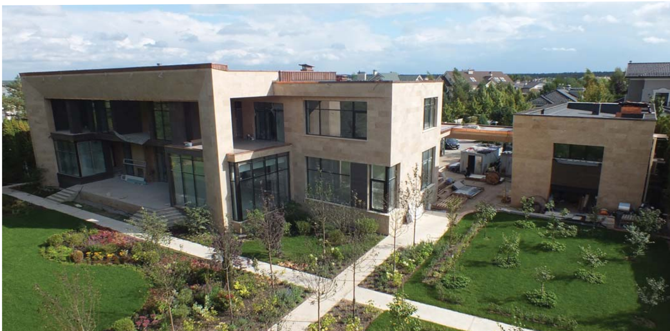
Рис. 1. Общий дворовый вид на главный дом и гараж с облицовкой фасадов из искусственного камня и медными парапетами.
