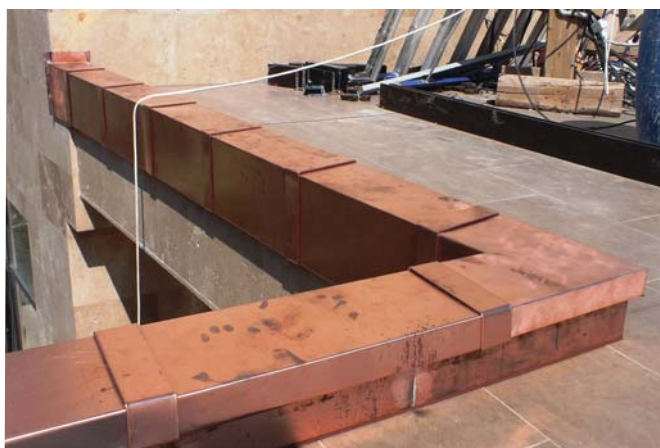
Рис. 14. Ограждение открытого балкона для защиты от непроизвольного схода воды по каменному фасаду во время сильных ливней с порывистом ветром выполнено в декоративной технике: элементы на внешней рейке с применением кровельного клея и низкотемпературной пайки.
