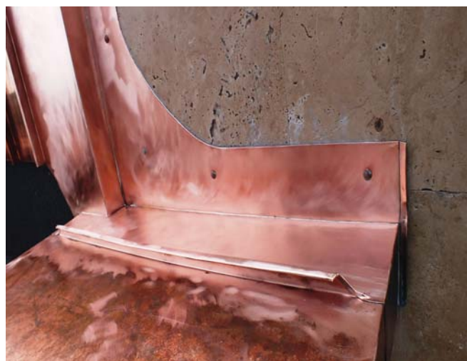
Рис. 7. Общий вид выполнения узлов из отдельных деталей в технике углового фальца 25 мм в области пересечения примыкания парапета с вертикальной стеной здания и применением технологии художественной пайки газовым паяльником. Полукруглые мысыки, декоративные колпачки, ослиное ушко и вертикальная снеговая защита камня.
