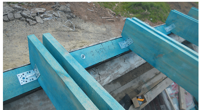
Рис. 11. Узел опирания составных стропильных ног на мауэрлат
