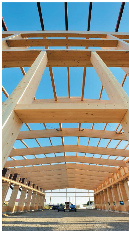
Различные стадии строительства BSH-конструкций
