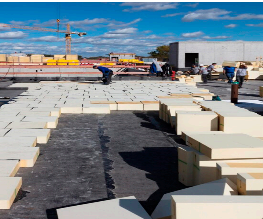
Укладка утеплителя кровли. Фото Puren
