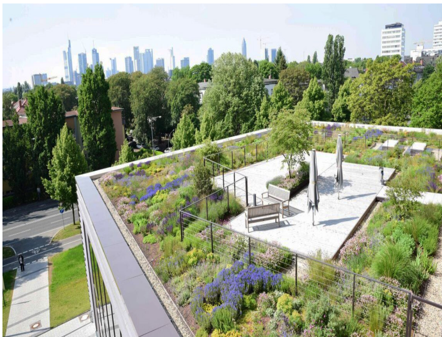
Рис. 1. «Зеленая кровля» здания Audimax (Франкфурт, Германия) Все фото и графика Optigrun international AG
