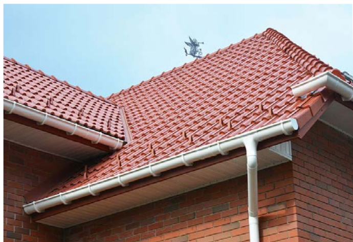
Рис. 8. Пример устройства водостоков
