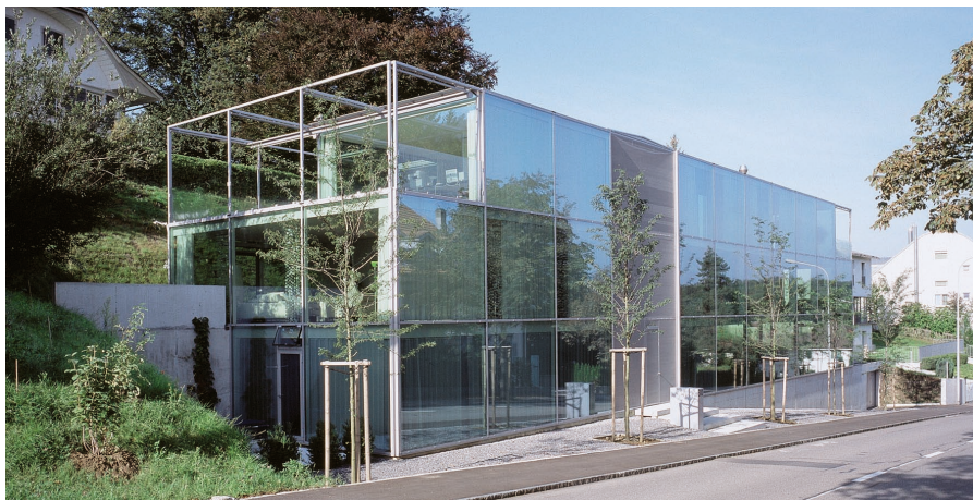
Новый стеклопакет SILVERSTAR TRIII E от компании EUROGLAS дает дополнительный выигрыш солнечной тепловой энергии и обеспечивает оптимальный энергетический баланс стеклянных фасадов.
