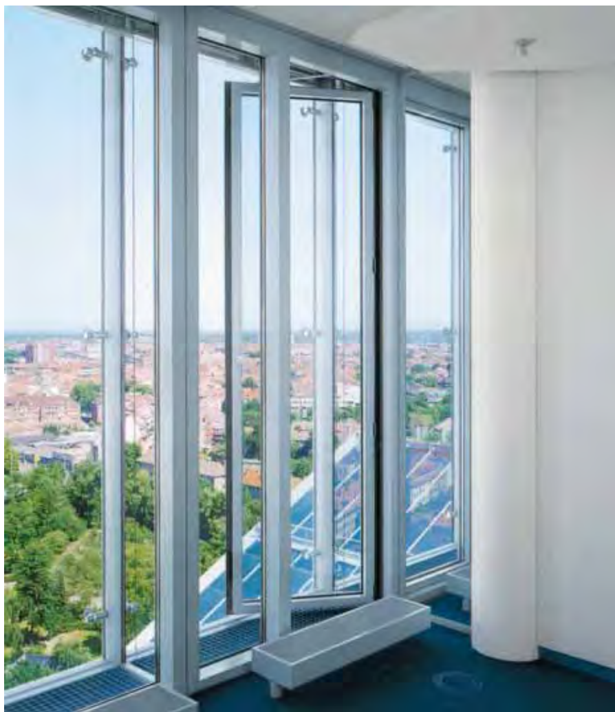
Вид двойного фасада изнутри корпуса А. Показана внутренняя открывающаяся створка для вентиляции и доступа к пространству между двумя лентами остекления
