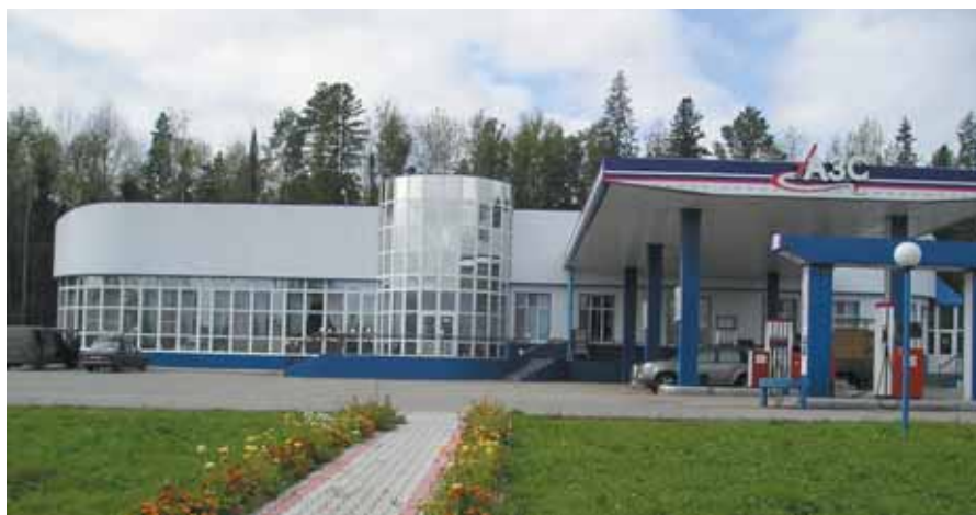
Монтаж с взаимным угловым перегибом секций до 8° позволяет выполнять фасады с закруглением горизонтального профиля
