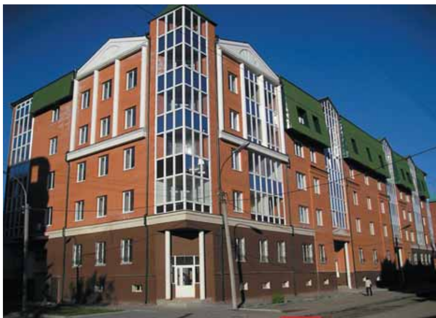
Сплошное ленточное остекление фасадов, балконов и лоджий можно тянуть на всю высоту здания.
