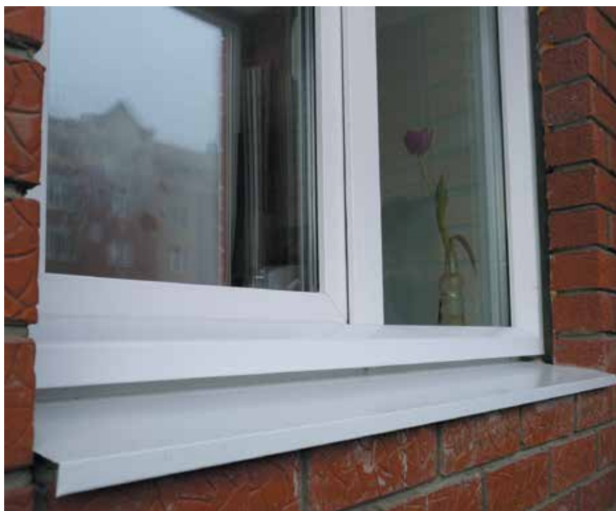
Отверстия забора воздуха с уличной стороны не видны, так как расположены снизу – на торце рамы
