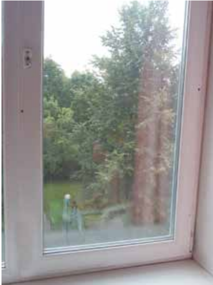
Сломанная створка заглушена саморезами
