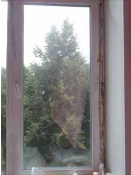
Следы заклейки скотчем дыры на притворе
