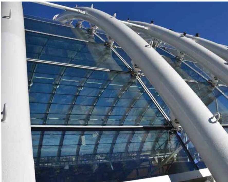
Система Planar предусматривает фиксацию панелей всего лишь в 4 точках. В этой связи огромное значение приобретает устойчивость к прогибу под действием собственного веса и максимальной снеговой нагрузки.
