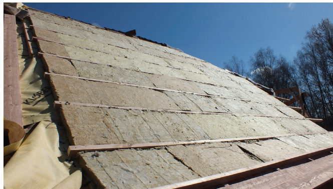
Общая толщина укладки теплоизоляции составила 200 мм
