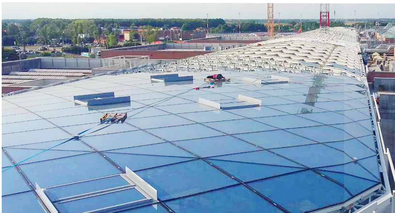
Панели крыши, созданные с использованием SentryGlas, — это технически сложные изделия с двойным стеклопакетом, треугольной или четырехугольной трапециевидной формы.
