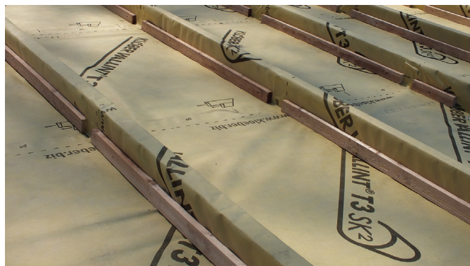
Завершение работ по санации кровли жилой мансарды
