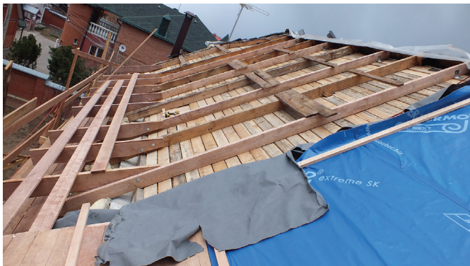
Монтаж кобылок на карнизном свесе кровли
