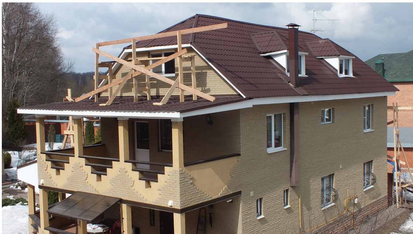
Общий вид кровли до начала реконструкции
