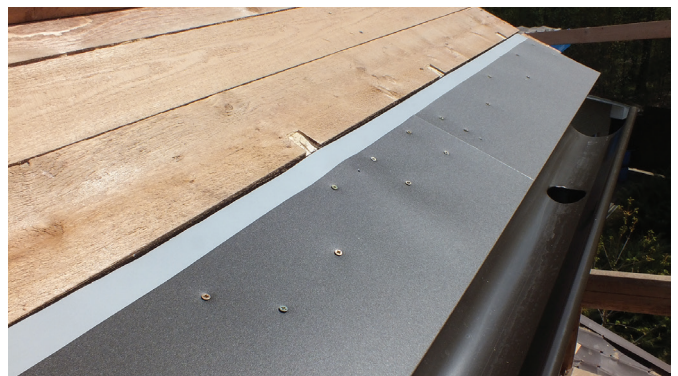
Монтаж стальной фальш- и алюминиевой карнизной планки
