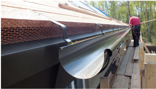
Монтаж водосточного желоба с видом установленных удлиненных крюков
