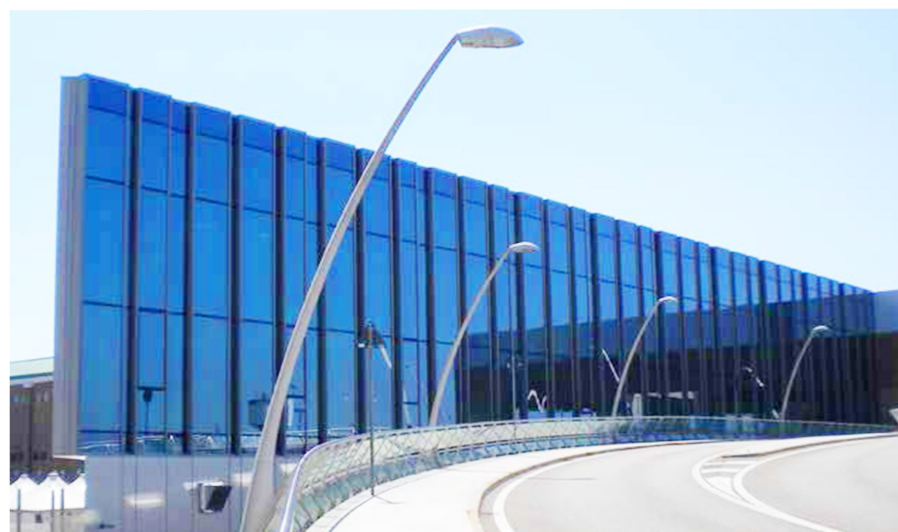
Однослойный материал Trosifol SC не только стабилизирует стекло, как и все ПВБ-прослойки, но и обладает невероятными свойствами защиты от шума, снижая его на 3 дБ эффективнее по сравнению со стандартными ПВБ-пленками.
