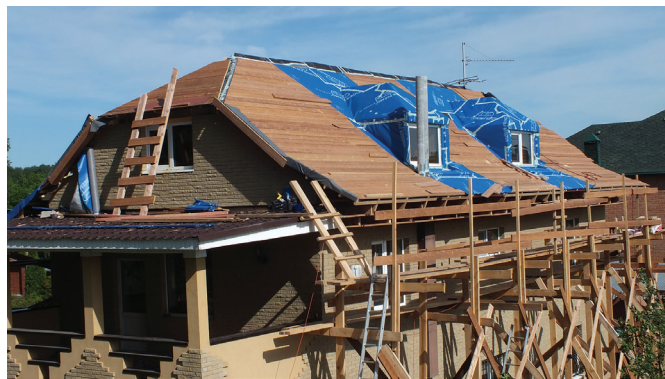
Общий вид финишного основания кровли перед укладкой черепицы
