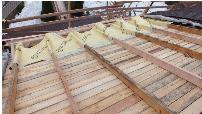
Начало санации кровли пленкой Wallint T3
