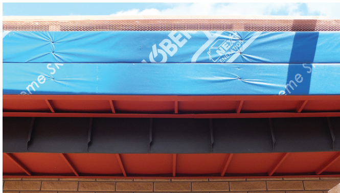
Общий вид обрамления карнизного свеса и вентиляционной сетки
