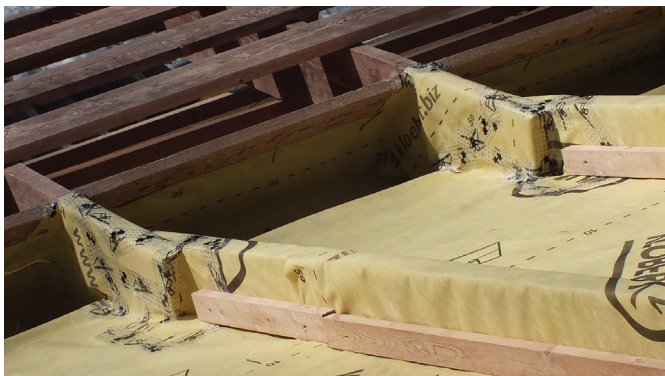
Узел сопряжения пароизоляции и стопорной доски теплоизоляции
