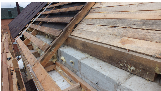
Локальный участок кровельной конструкции после вскрытия
