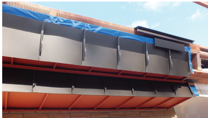
Сборка элементов в зоне притока воздуха для вентиляции подкровельного пространства
