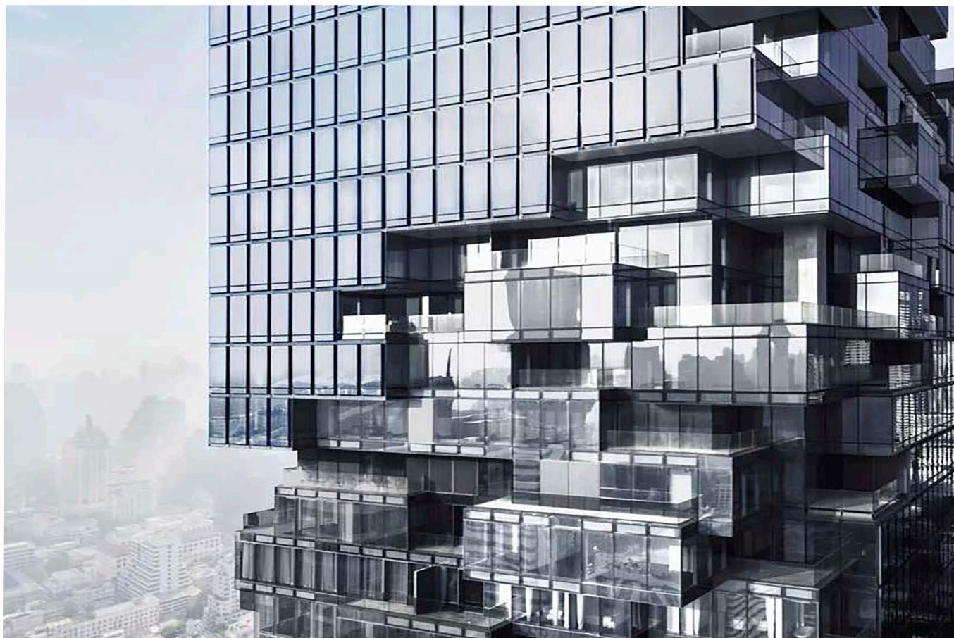
Характерный разрез, который охватывает здание, при взгляде издалека придает ему незаконченный вид.
