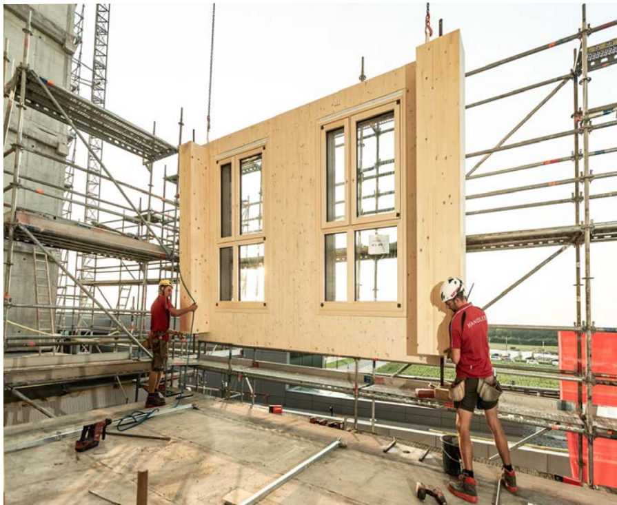
На этапе строительства
