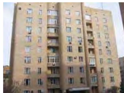
Рис. 2. Кирпичное здание, облицованное пустотелым керамическим кирпичом, построенное в Москве в 1978-1980 гг.
