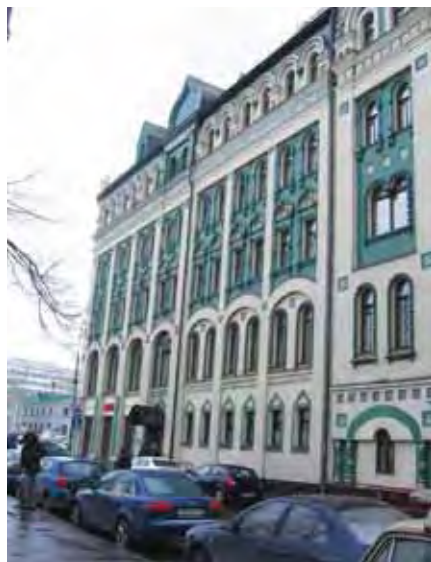
Рис. 1. Кирпичное здание с наружными стенами, облицованными полнотелым керамическим кирпичом (построено в 1895-1900 гг. в Москве).
