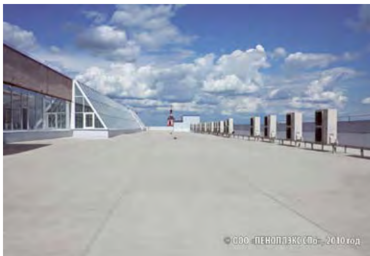
Фото 1. Кровля гостиничного комплекса, Рязань
