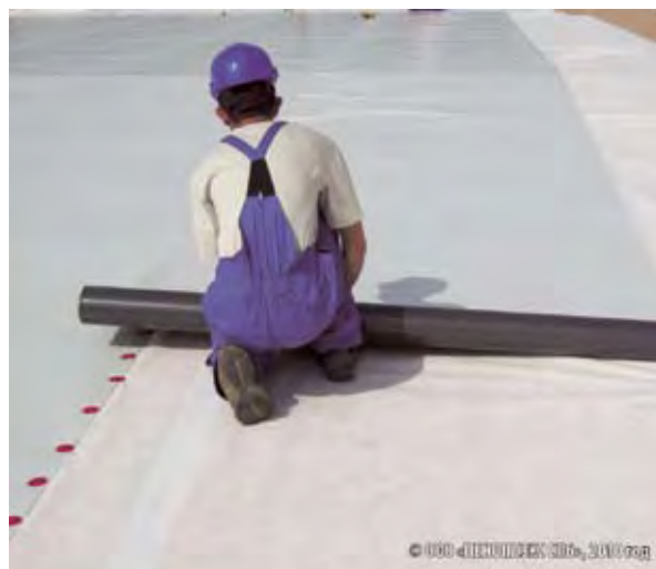
Фото 2. Кровля складского терминала, Санкт-Петербург
