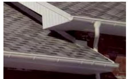
Ошибки: отсутствует оклад вокруг мансардного окна; на замену металлических планок примыкания дымоходной трубы выступил ендовный ковер, который уложен поверх гибкой черепицы
