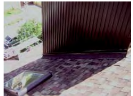
Ошибки: отсутствует оклад вокруг мансардного окна; на замену металлических планок примыкания дымоходной трубы выступил ендовный ковер, который уложен поверх гибкой черепицы
