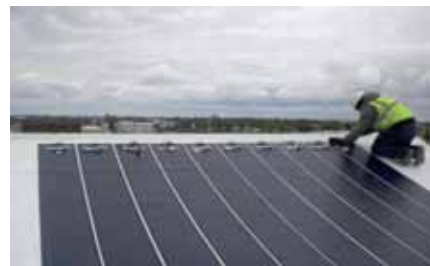
Система EverGuard® Extreme™ Advanced Heat & UV Protection TPO-мембрана была выбрана из-за ее способности противостоять высоким температурам и воздействию УФ-излучения
