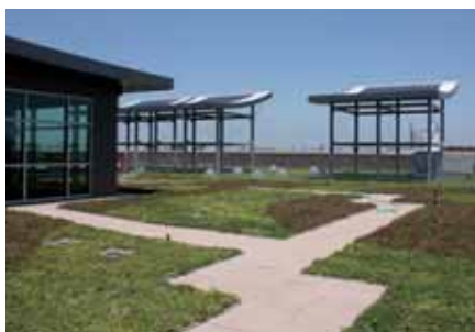
Зеленая кровля здания Палаты общин Графства
