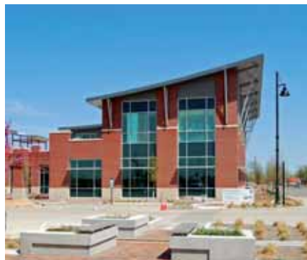
Часть завершенной кровельной системы
