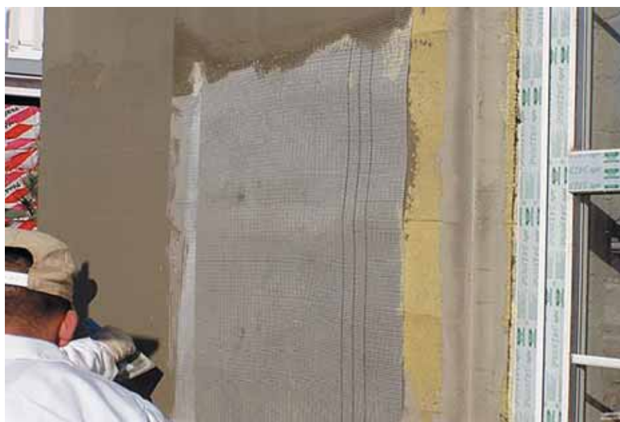
Рис. 5. Втапливание армирующей сетки
