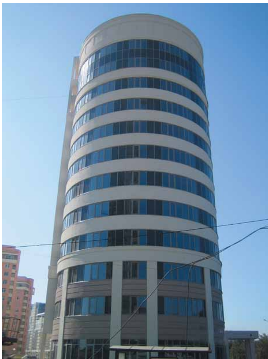
Москва, Ходынка, офисное здание
