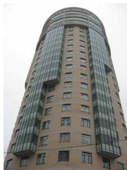
Москва, жилой дом
