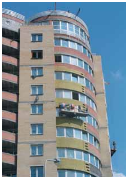
Рис. 7. Сложный фасад с применением ламельных плит PAROC FAL 1
