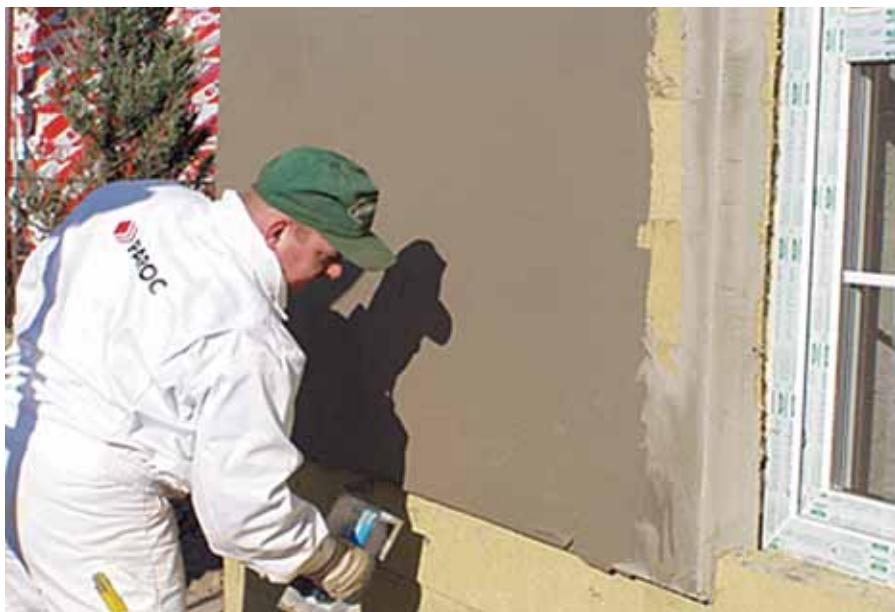
Рис. 6. Нанесение финишного слоя
