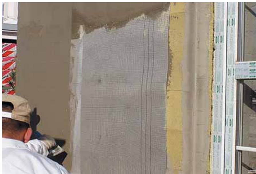
Рис. 5. Втапливание армирующей сетки
