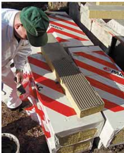
Рис. 3 Нанесение клеевого состава на плиту PAROC FAL 1
