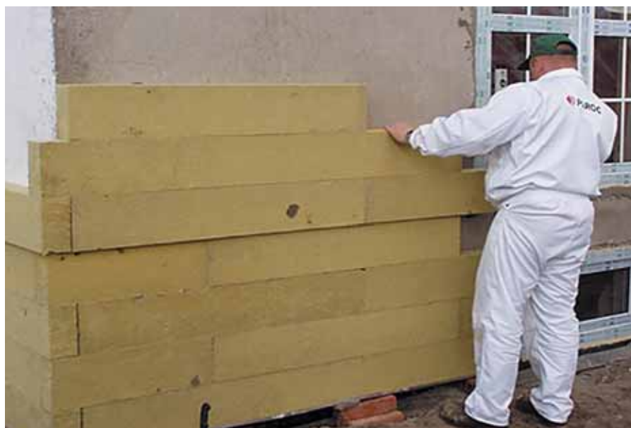
Рис. 4. Приклеивание плит с перевязкой швов
