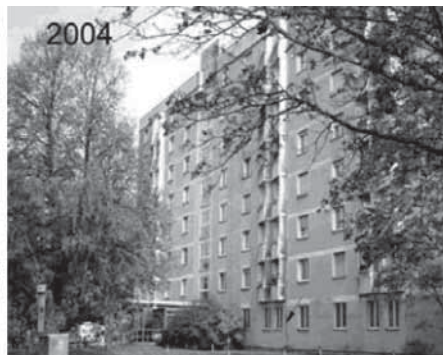
Рис. 6. Западный фасад объекта 16 (Дом престарелых в Мюнхене) в сентябре 1989 г., через 3 года после применения СФТК, и в ноябре 2004 г., спустя 15 лет.
