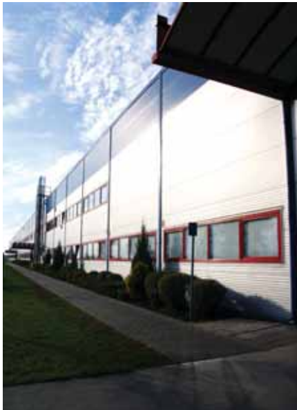
Производственный корпус Winkhaus Polska
