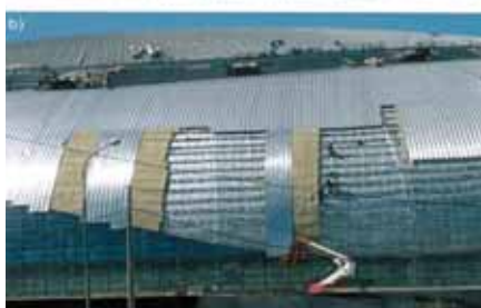
Рис. 11. Последовательность монтажа: а) на крыше, б) на стене
