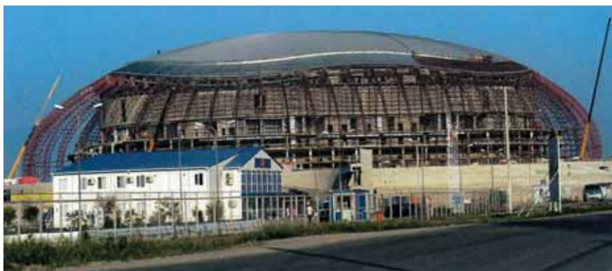
Рис. 5. Ледовый дворец во время строительства
