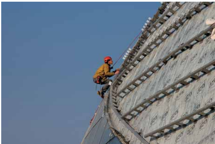
Рис. 10. Контрольный монтаж профилированных листов на стену
