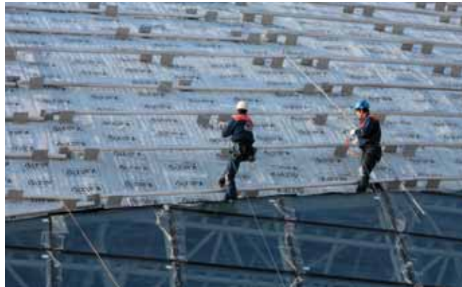
Рис. 15. Алюминиевые трубы как помощь в восхождении
