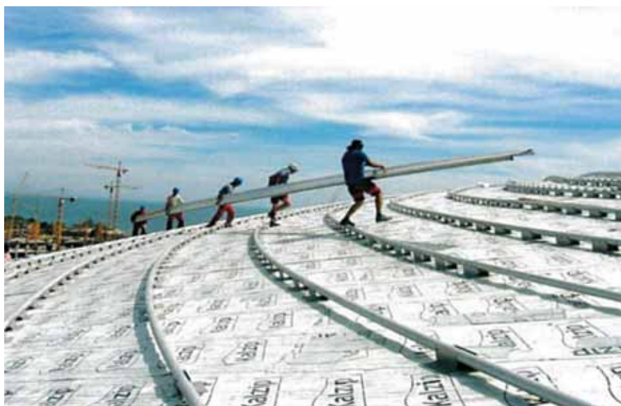
Рис. 13. Перемещение профилированных листов по крыше
