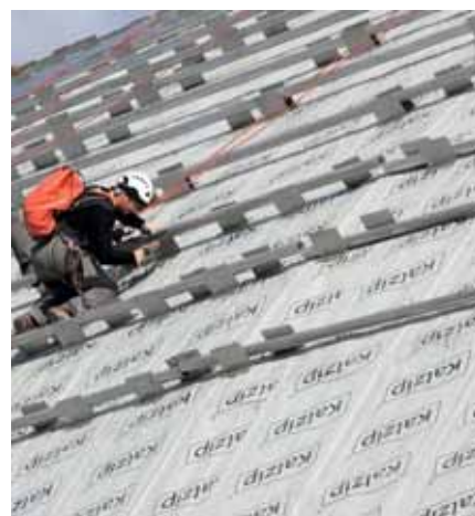
Рис. 15. Алюминиевые трубы как помощь в восхождении
