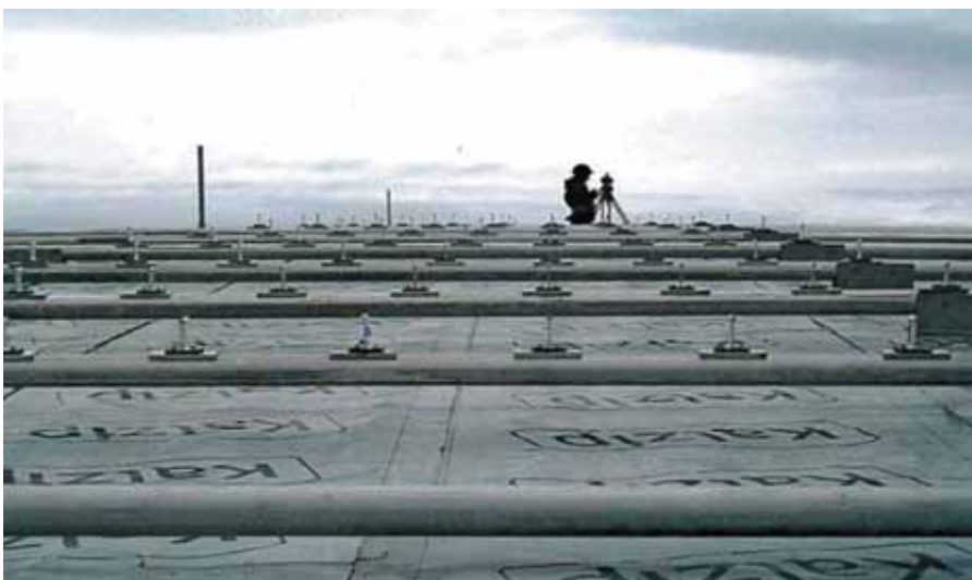
Рис. 9. Юстировка клип-опор по высоте, осям и уклону
