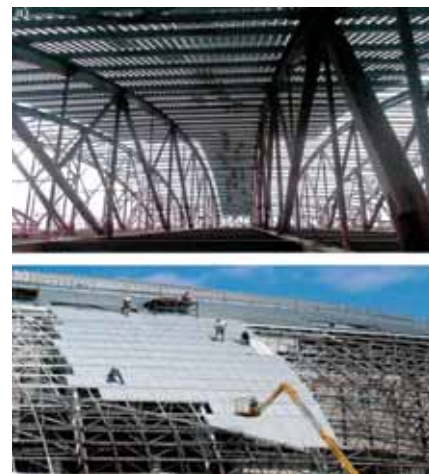
Рис. 6. Несущий настил кровли Ледового дворца: а) изнутри, б) снаружи
