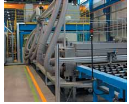
Новая линия магнетронного напыления
