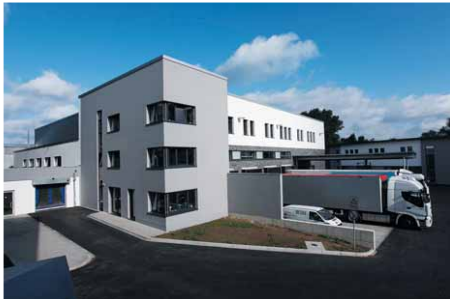
Завод Winkhaus в Тельgte
