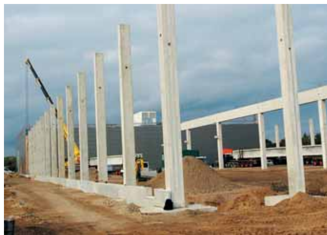
Стройплощадка нового производственного предприятия в Мюнстере
