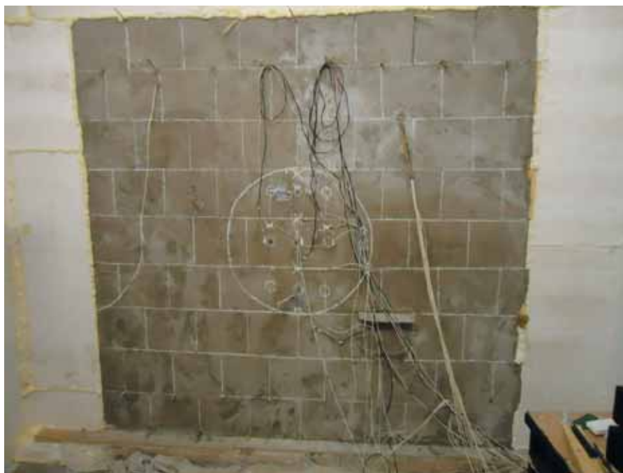
Рис.3. Вид внутренней оштукатуренной поверхности фрагмента стены в процессе установки термодатчиков.
