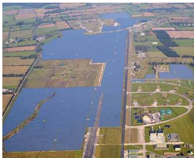
Солнечная станция в г. Эггебеке (Германия)
