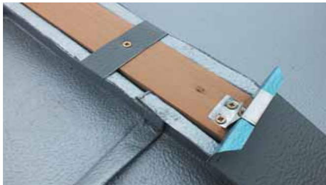
Узел крепления декоративных рядовых реечных элементов
