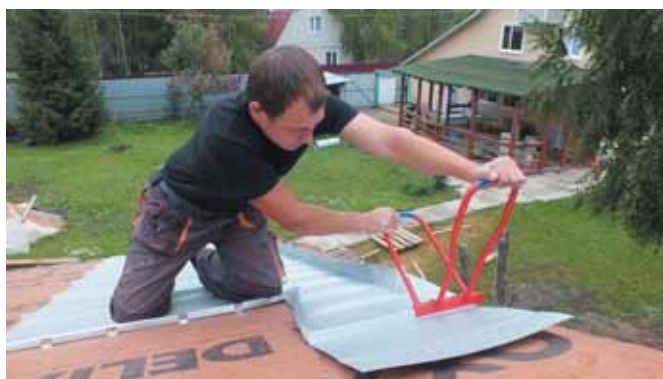
Обжим фальцевых картин специальным инструментом – универсальной рамкой STUBAI
