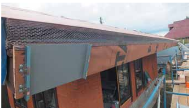
Установка декоративных картин требует качественной подготовки поверхности лобовой доски (сушка, строгание, шлифовка, покраска)
