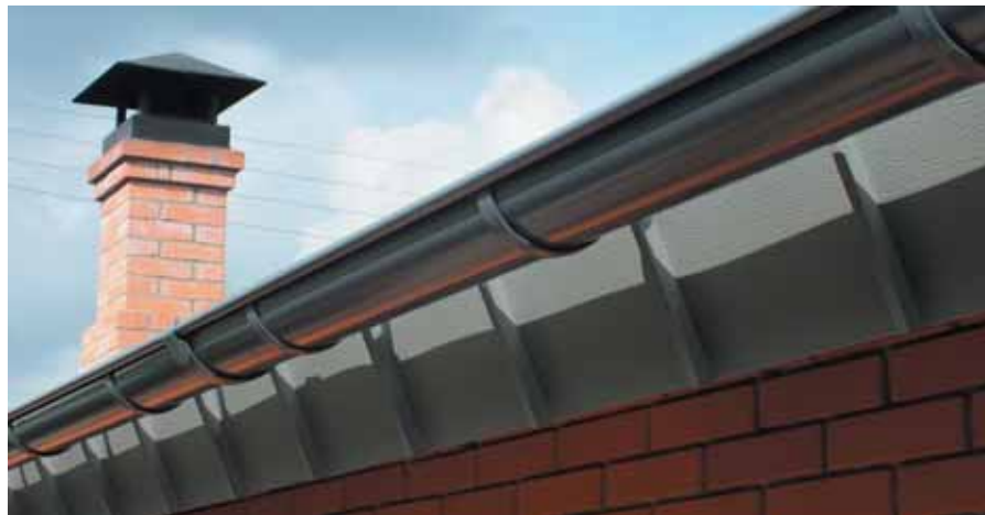
Монтаж полукруглого внешнего водосточного желоба
