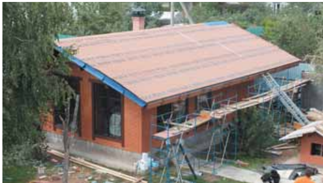
Укладка разделительного слоя в виде диффузионной мембраны
