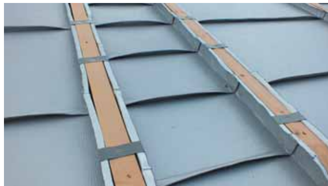
Двухстороннее крепление боковых частей картин кляммерами;
