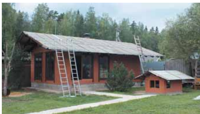
Первоначальное кровельное покрытие объекта на период зимней консервации было покрыто рубероидом
