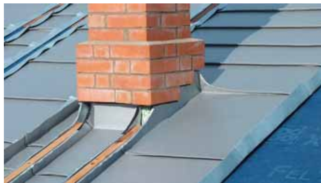
Обход дымоходной трубы в технике реечного фальца
