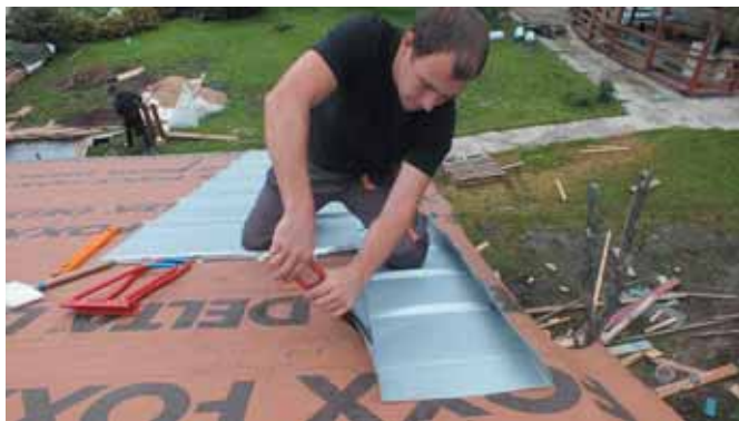
Отбортовка боковых частей картины конвертными клещами
