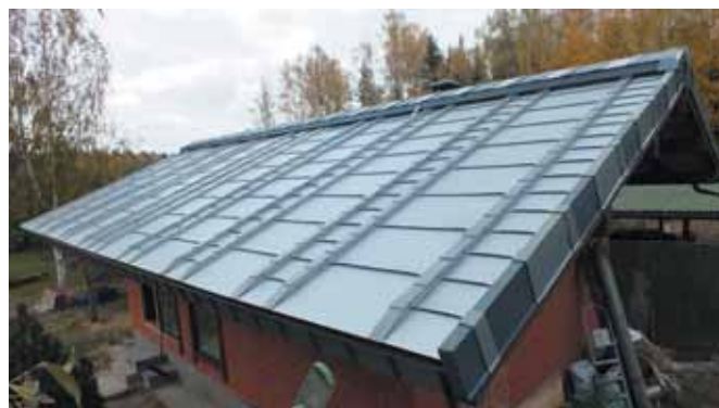
Общий вид кровли в старинной утраченной технике реечного фальца ручной работы
