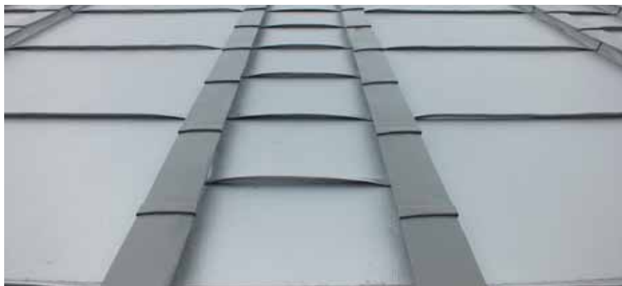
Готовый вид декоративных реечных элементов высотой 50 мм
