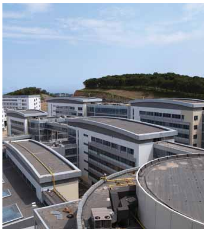
Дальневосточный федеральный университет, г. Владивосток. Окраска бетонных полов краской Terafloor 150
