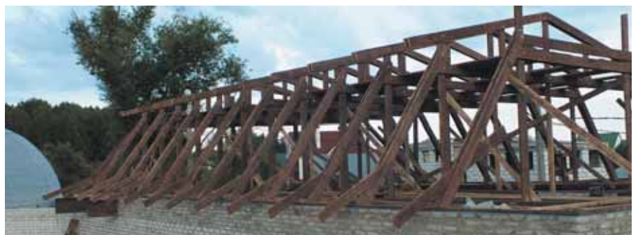
Монтажно-сборочные работы фермы наслонно-висячего типа с шириной внутреннего безопорного пролета 6200 мм
