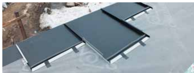
Начало укладки фальцевых картин в шахматном порядке (сетчатый узор) на пологой части кровли (16 градусов)
