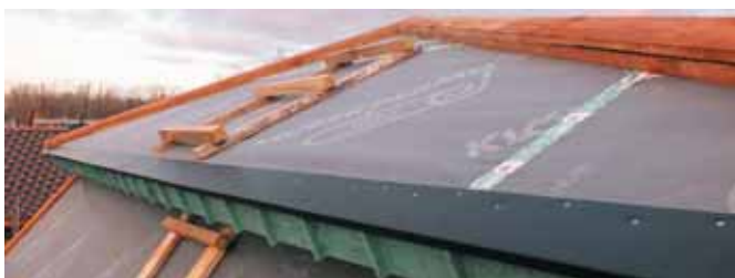
Общий вид карнизного свеса вальмовой кровли с установкой скрытых выравнивающих фальш-планок и карнизных планок на нержавеющей саморезах
