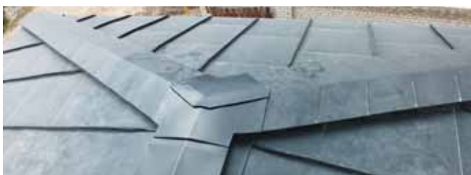
Вальмовый узел сопряжения конькового элемента с двумя диагональными хребтами
