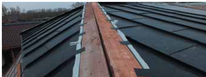
Примыкание рядовых фальцевых картин с отбортовкой 30 мм и их фиксации на кляммерах к хребту вальмовой кровли
