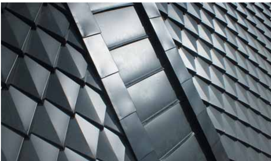
Гибридная техника применения реечного фальца и штучной черепицы в формате малого объемного ромба с внешним центральным переломом
