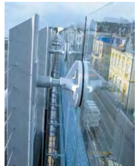
Рис. 9. Установка спайдерного крепления на стыке стекол в вырезах.
