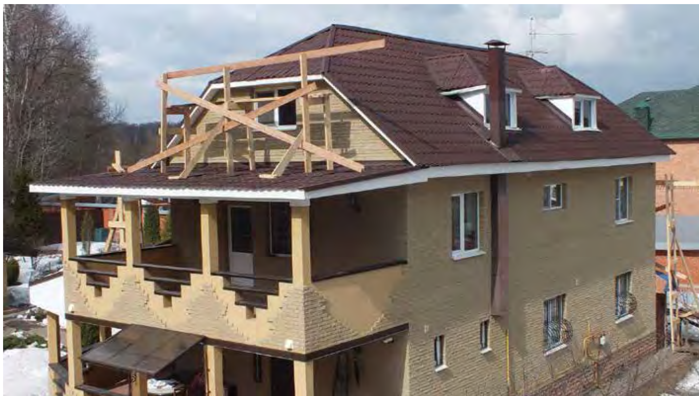
Общий вид кровли до начала реконструкции
