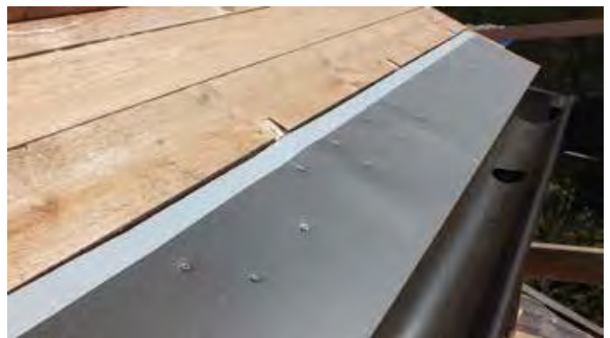
Монтаж стальной фальш- и алюминиевой карнизной планки
