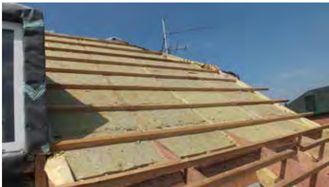
Для исключения мостиков холода произвели поперечную укладку теплоизоляции
