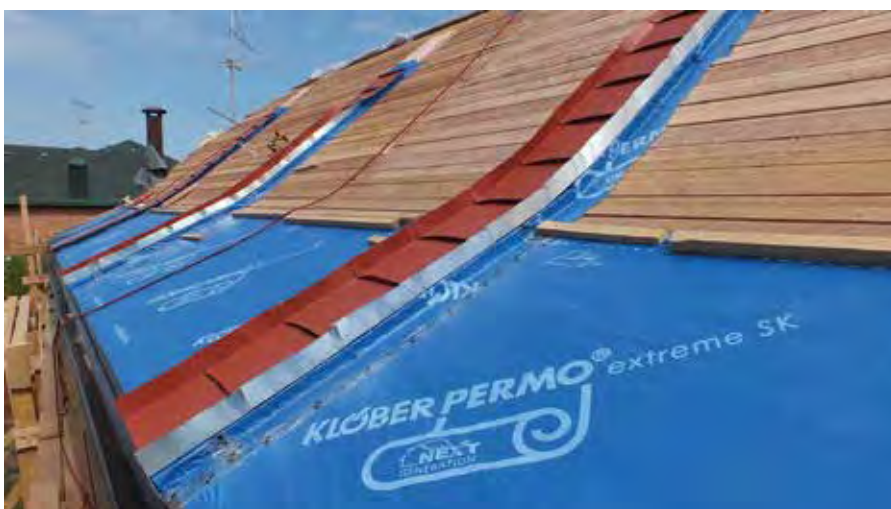
Общий вид установленных картин реечного фальца с разделением на зоны
