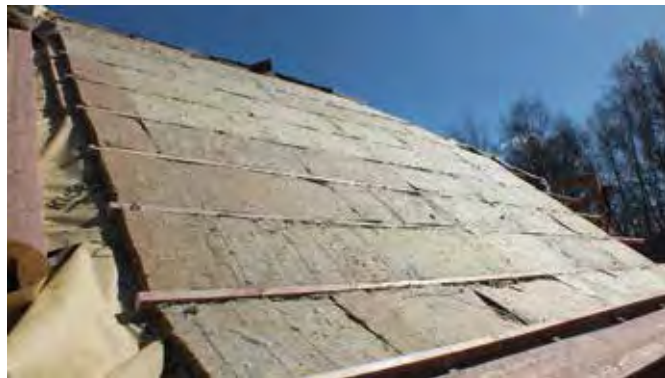
Общая толщина укладки теплоизоляции составила 200 мм
