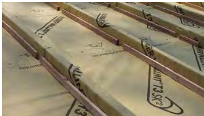
Завершение работ по санации кровли жилой мансарды
