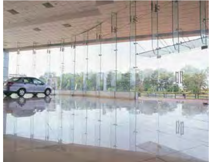
Рис. 8. Спайдерное крепление фасада, ребер жесткости и козырька
