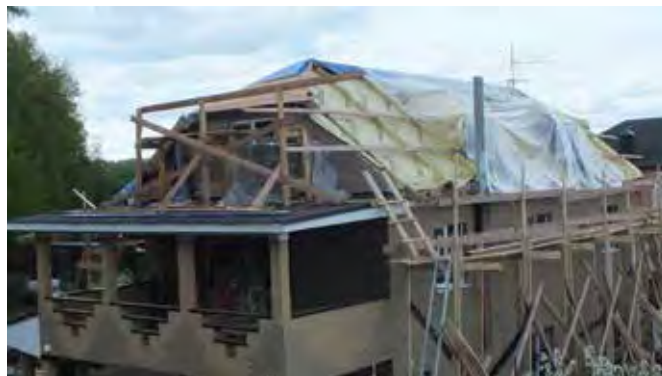
Во время сезона дождей кровлю укрывали пленкой от внешних осадков
