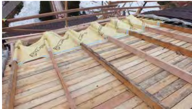
Начало санации кровли пленкой Wallint T3
