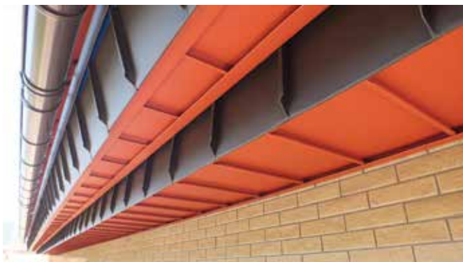
Общий вид снизу подкарнизного свеса и водосточного желоба
