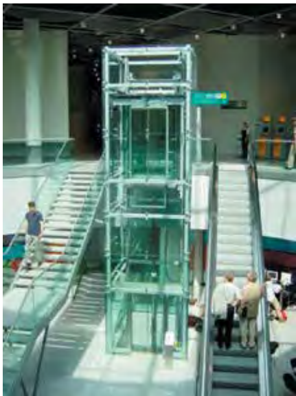
Рис. 4. Остекление шахты лифта
