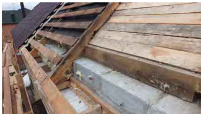
Локальный участок кровельной конструкции после вскрытия
