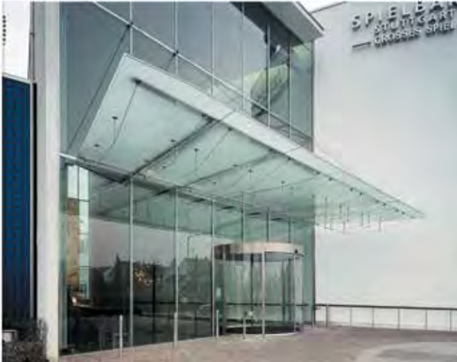
Рис. 7. Крепление стеклянных козырьков
