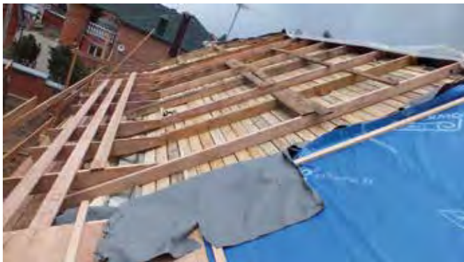
Монтаж кобылок на карнизном свесе кровли
