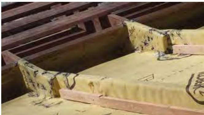
Узел сопряжения пароизоляции и стопорной доски теплоизоляции
