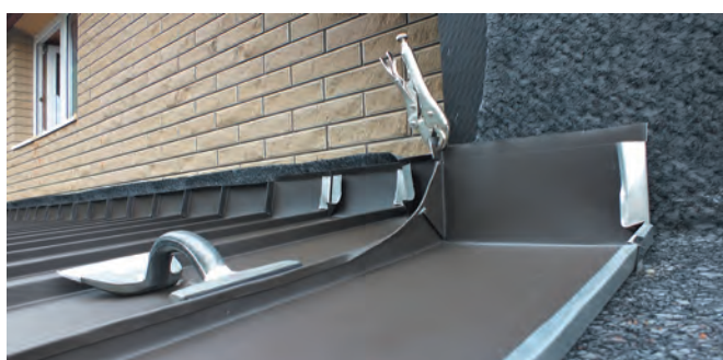
е) вид угловой картины со стороны внутреннего свернутого шва с переходом из двойного в одинарный фальц и применением ручной лопатки (шалайзен), имеющей специальную обрешиненную основу для работы с полимерными покрытиями металлов
