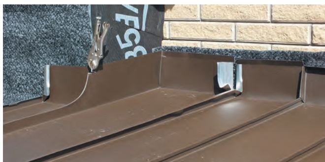
д) общий вид угловой картины, соединенной между рядовыми картинками в одинарный фальц (первый проход)
