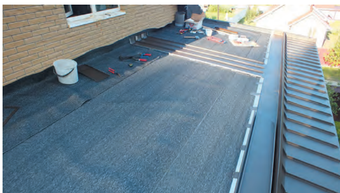
Общий вид верхнего пологого навеса с укладкой объемной диффузионной мембраны KLOBER Sec Metal и началом монтажа фальцевых картин
