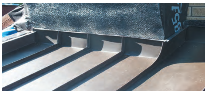
з) общий вид завершения работ по монтажу фальцевых картин имеющих прямой, лотковый и полукруглый конверты, с примыканием к вертикальным частям здания и кровли в целом
