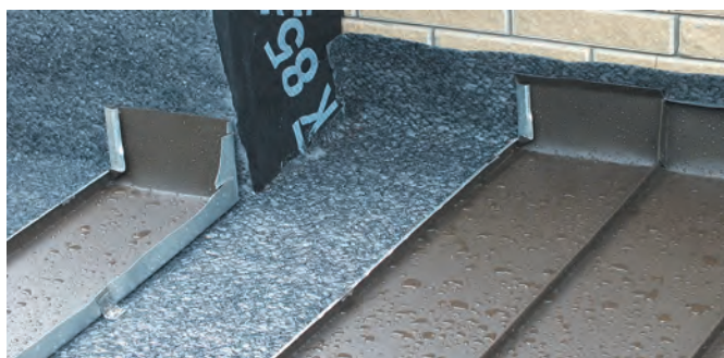
а) общий вид внутреннего и внешнего углов деревянного короба фронтонного свеса кровли, сопряженный с нижележащим навесом в процессе укладки фальцевых картин шириной 220 мм
