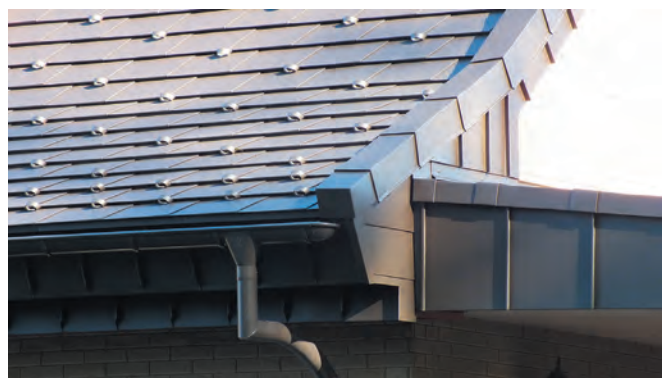
Общий вид сопряжения двух фронтовых углов кровли и навеса с их декоративным оформлением и водосточной системой
