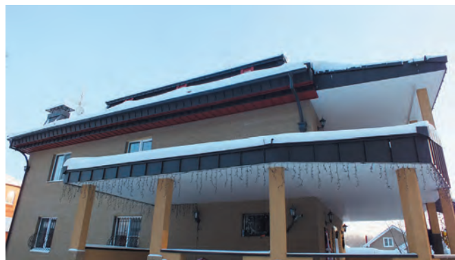
Венчающие карнизные части кровли и навесов декорированы малыми и большими фальцевыми картинками
