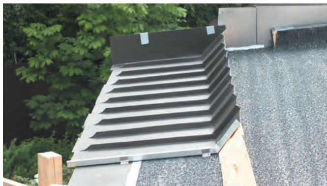
Процесс укладки малых фальцевых картин с подрезкой полукруглых мысиков и примыканием к лежащему водостоку
