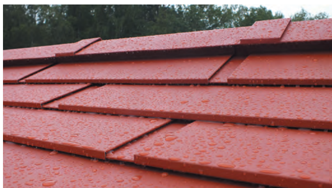
Рядовое покрытие – плоский гонт на внутренней рейке; наверху – элемент на внешней рейке
