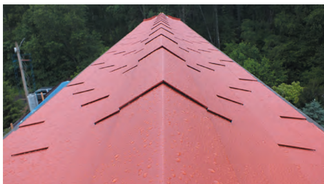
Радиусная поверхность коньковой части кровли покрыта плоским гонтом на внутренней рейке на высоте более 12 м без использования лесов
