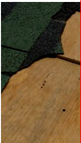
Ошибки: не выпилены пазы для ФФС для линейного расширения в период
