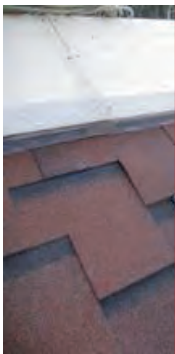
(2) Монтаж сплошной гидроизоляции не менее 9 мм. Гидроизоляция монтируется при помощи планки
