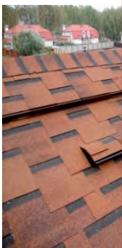
Вентилируемый карнизными элементами (общий вид)
