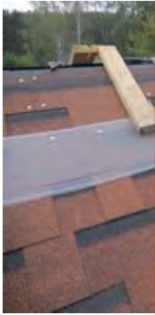
(1) Монтаж бруса с противомоскитной сеткой шириной 100 мм
