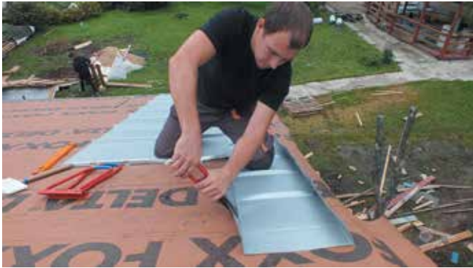
Отбортовка боковых частей картины конвертными клещами
