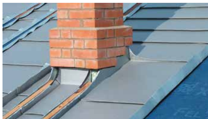
Обход дымоходной трубы в технике реечного фальца
