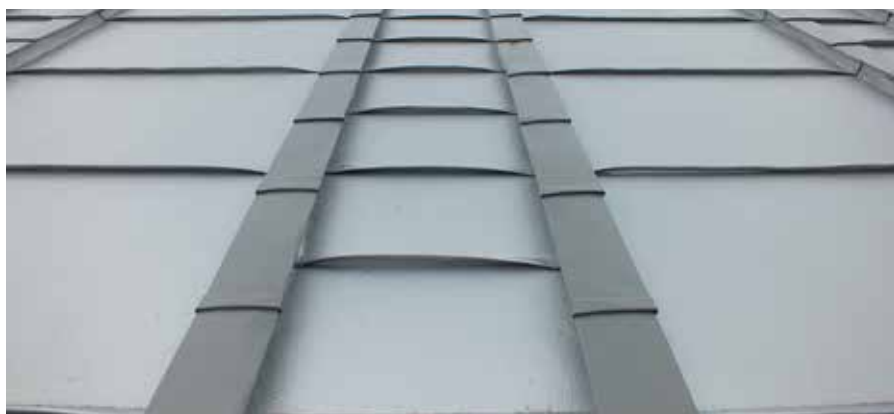
Готовый вид декоративных реечных элементов высотой 50 мм
