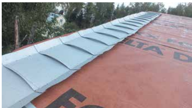
Монтаж первого ряда фальцевых картин вдоль фронтонного свеса кровли (бельгийский вариант)
