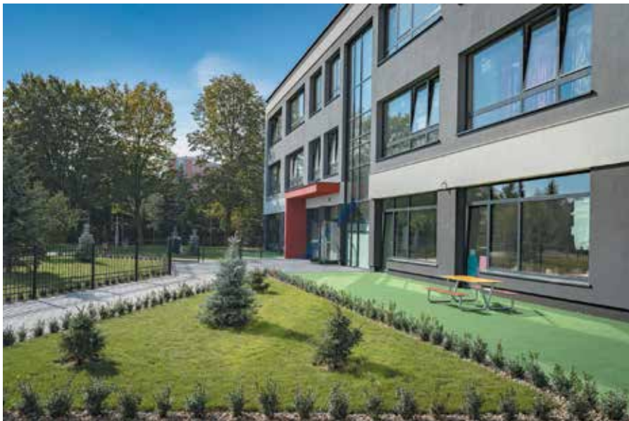
Новое здание Международной Школы в Познани с современной системой вентиляции от Winkhaus
