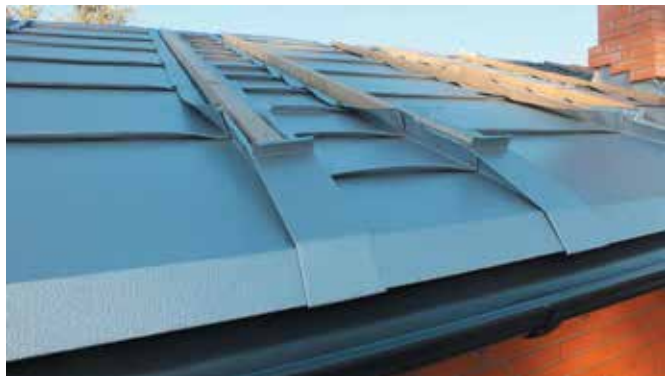
Установка начальных декоративных заглушек в карнизной зоне кровли (шведский вариант)
