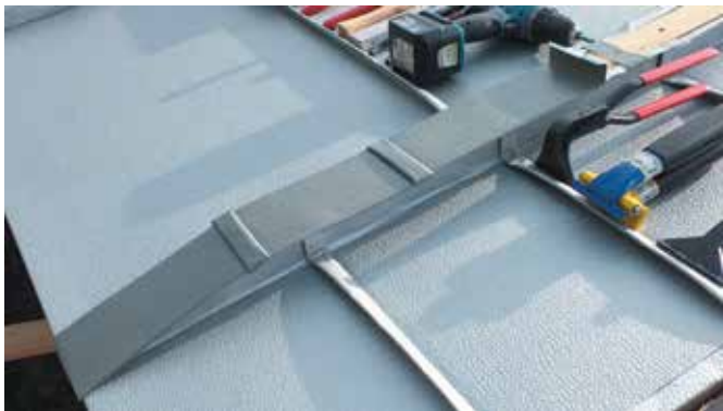
Установка начальных декоративных заглушек в карнизной зоне кровли (бельгийский вариант)
