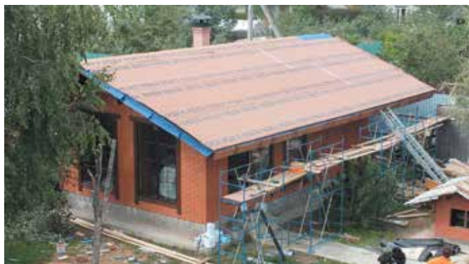
Укладка разделительного слоя в виде диффузионной мембраны
