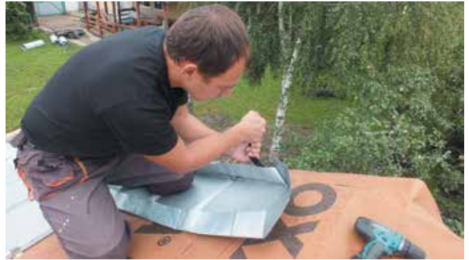
Свертывание угла (конверт) картины в коньковой части кровли специальным инструментом – цаплей
