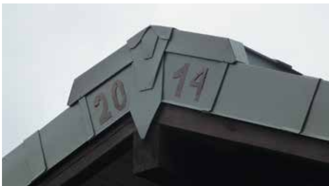
Элементы декорации вентилируемого конька со стороны фронтона
