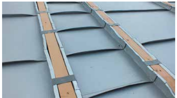
Двухстороннее крепление боковых частей картин кляммерами;
