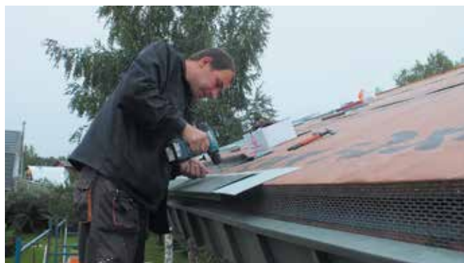
Установка на карнизном свесе кровли фальш- и карнизной планок
