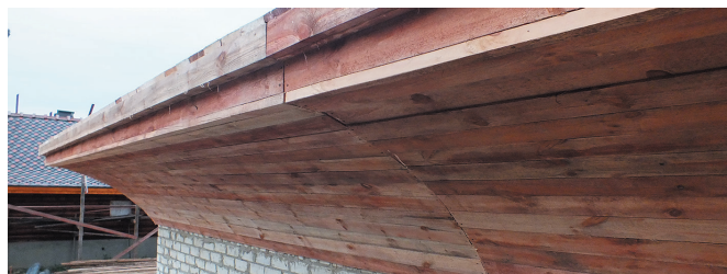
Карнизные радиусные зоны кровли после завершения плотницких работ
