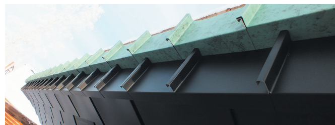
Обрамление двухуровневой лобовой доски выполнено в виде малых фальцевых картин закрепленных в шахматном порядке (техника декоративного Г-образного стоячего фальца)
