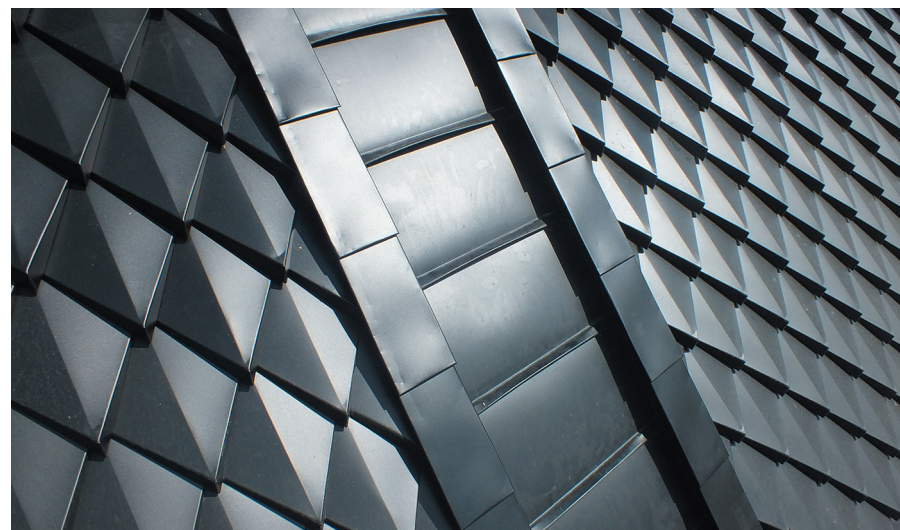
Гибридная техника применения реечного фальца и штучной черепицы в формате малого объемного ромба с внешним центральным переломом
