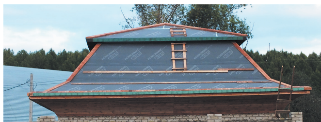
Общий вид кровли с юго-восточного фасада здания
