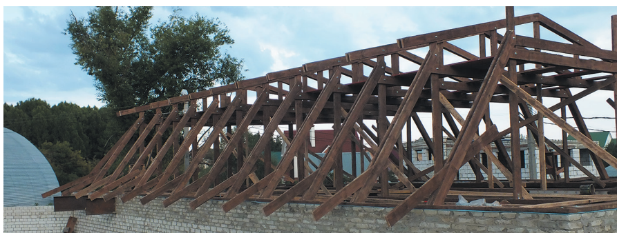
Монтажно-сборочные работы фермы наслонно-висячего типа с шириной внутреннего безопорного пролета 6200 мм
