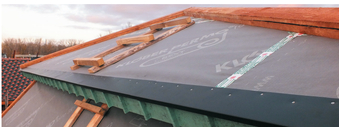
Общий вид карнизного свеса вальмовой кровли с установкой скрытых выравнивающих фальш-планок и карнизных планок на нержавеющей саморезах
