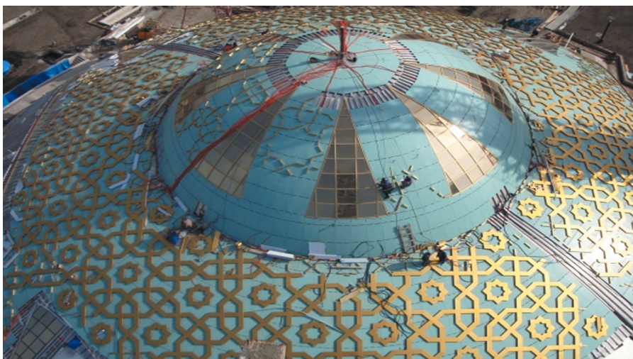
Установка золотистого орнамента. Фото: Kalzip
