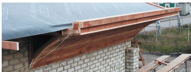
Вид конструкции внутреннего шедового желоба и радиусного карнизного свеса кровли с элементами двухуровневой лобовой части карниза
