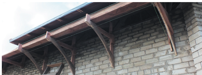
Этап работы по установке и монтажу вогнутой радиусной части карнизного свеса кровли с длиной дуги 900 мм
