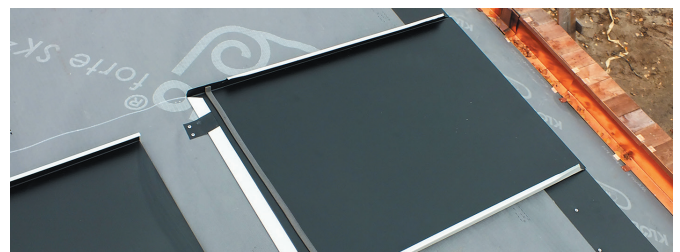
Укладка первой рядовой фальцевой картины на карнизном свесе кровли с применением самоклеящейся ленты ПСУЛ шириной 10 мм
