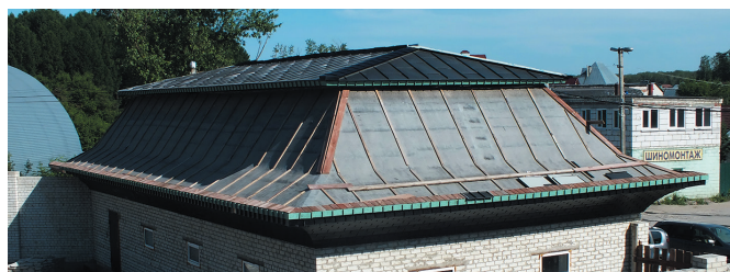
Вид кровельной конструкции после укладки фальцевых картин и плоского гонта
