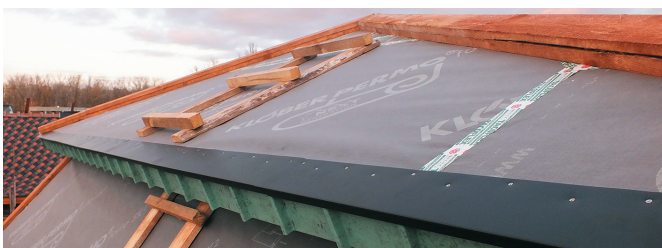
Общий вид карнизного свеса вальмовой кровли с установкой скрытых выравнивающих фальш-планок и карнизных планок на нержавеющей саморезах
