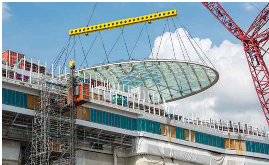
Купол SkyDome был собран непосредственно рядом с судном на верфи Папенбурга, а затем поднят на 18-ю палубу одним движением.
