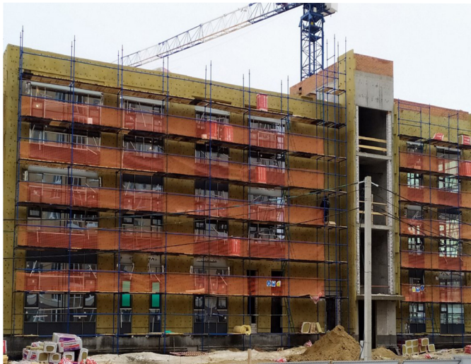
Строительство полилингвальной школы «Адымнар» в Казани
