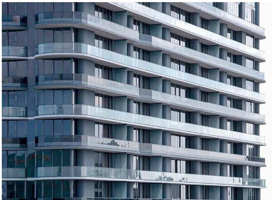
Снаружи Brickell Flatiron представляет собой море стекла, со значительной площадью остекления и балюстрадами на каждом этаже.
