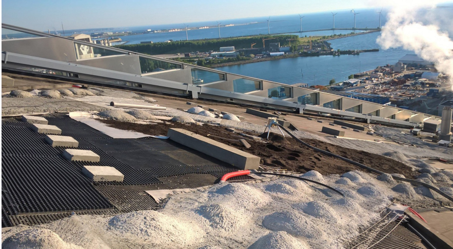
Дренажные элементы ZinCo Protectodrain PD 250 устанавливаются вокруг бетонированных опор, рядом с холмистыми горными тропами
