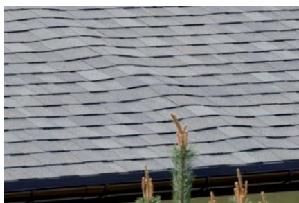
Ошибки: деформационные волны образовались из-за отсутствия зазоров между листами фанеры при ее укладке
