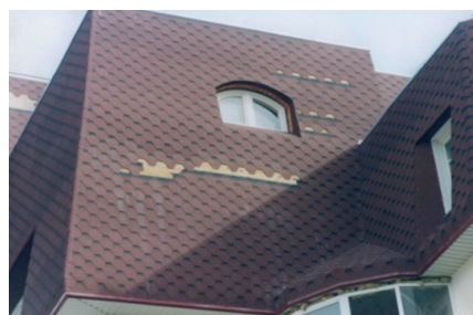
Ошибки: крепление гонтов черепицы произведено с недостаточным количеством гвоздей, что привело к их отрыванию при порывах ветра
