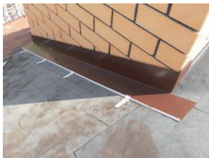
(5) Крепление примыкания к трубе на неподвижных кляммерах
