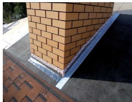
(3) Укладка подкладочного ковра вокруг дымоходной трубы
