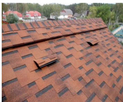
Вентилируемый конек с точечными аэраторами (общий вид)
