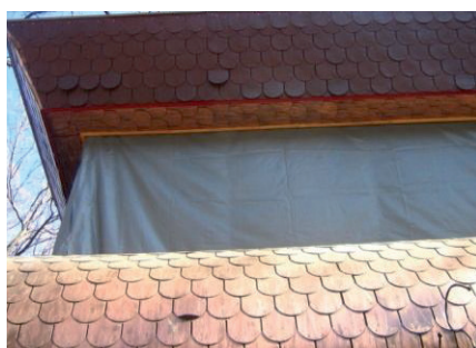
Ошибки: лепестки рядовой черепицы на отвесной вертикальной поверхности дополнительно не были промазаны битумной мастикой
