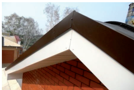
Вид торцевой планки на фронтонном свесе с металлическими элементами (вид сбоку)
