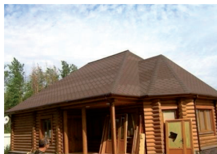
Ошибки: перепад цветового оттенка образован вследствие отсутствия перемешивания гонтов черепицы из разных упаковок
