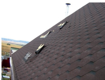
Ошибки: отклеивание лепестков гибкой черепицы с медным покрытием импортного производства связано с использованием более дешевого окисленного битума по сравнению с более пластичным СБС-модифицированным битумом и небрежным монтажом материала
