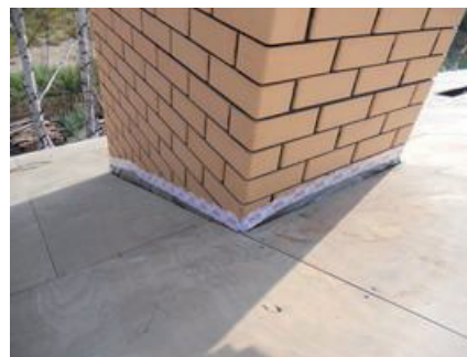
(1) Проклейка мембраны скотчем к трубе
