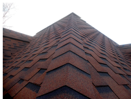
Общий вид коньково-карнизной черепицы на хребте кровли
