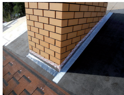
(3) Укладка подкладочного ковра вокруг дымоходной трубы
