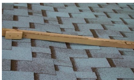
Ошибки: плоскость ската нарушена из-за неправильно смонтированной стропильной системы и сплошного основания
