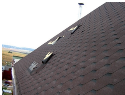
Ошибки: отклеивание лепестков гибкой черепицы с медным покрытием импортного производства связано с использованием более дешевого окисленного битума по сравнению с более пластичным СБС-модифицированным битумом и небрежным монтажом материала
