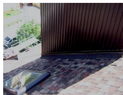
Ошибки: отсутствует оклад вокруг мансардного окна; на замену металлических планок примыкания дымоходной трубы выступил ендовный ковер, который уложен поверх гибкой черепицы
