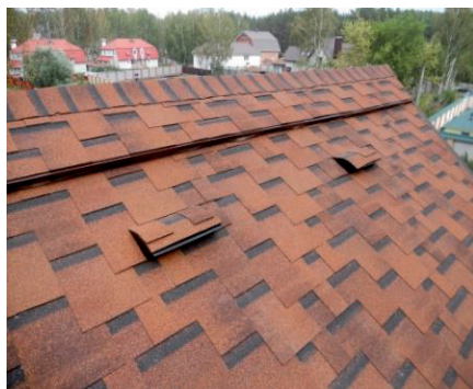
Вентилируемый конек с точечными аэраторами (общий вид)
