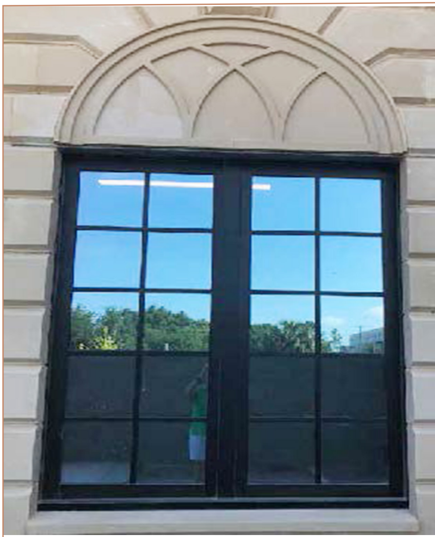
Окна спроектированы таким образом, чтобы выдерживать любые капризы природы, в том числе благодаря слоям ионопласта SentryGlas.
