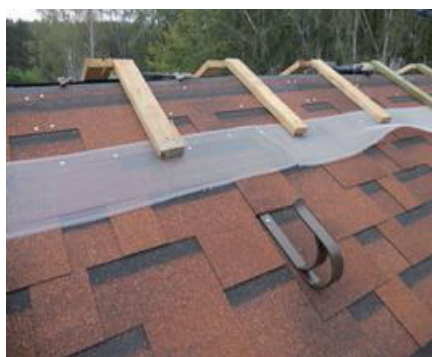
(1) Монтаж брусков высотой 50 мм с противомоскитной алюминиевой сеткой шириной 100 мм
