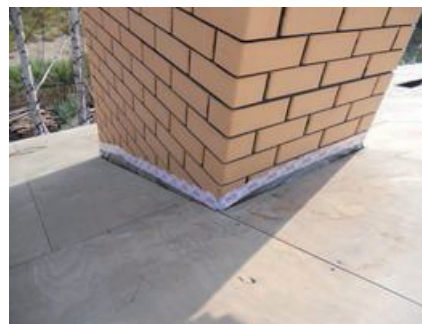
(1) Проклейка мембраны скотчем к трубе
