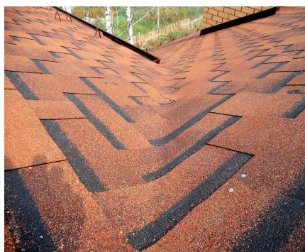
(2) Общий вид ендовы выполненной методом «косичка»
