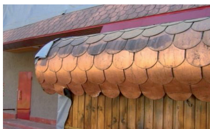
Ошибки: отклеивание лепестков гибкой черепицы с медным покрытием импортного производства связано с использованием более дешевого окисленного битума по сравнению с более пластичным СБС-модифицированным битумом и небрежным монтажом материала
