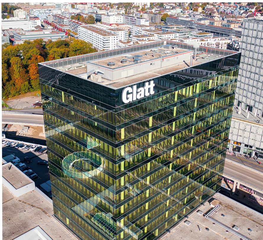
Спустя 40 лет башню Глатт в Валлизеллене, Швейцария, пришлось отремонтировать. Башня получила новую оболочку здания, оснащенную смарт-стеклом фирмы SageGlass
