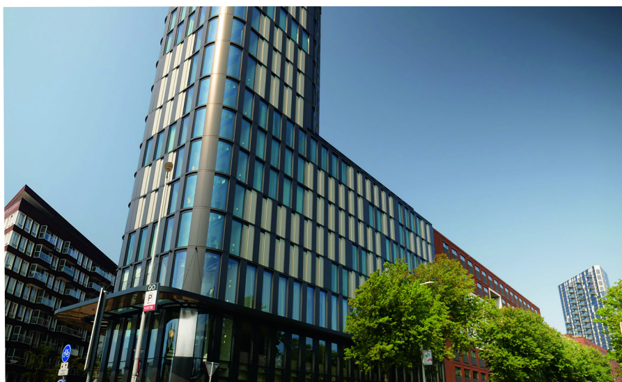
Фасад отеля в Амстердаме с электрохромным стеклом, изготовленный фирмой Huesk
