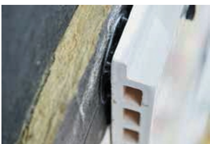
Три компонента входят в систему «Fixrock BWM Brandriegel Kit»: жесткая изоляция, мягкая изоляция и специальные пластиковые дюбели
