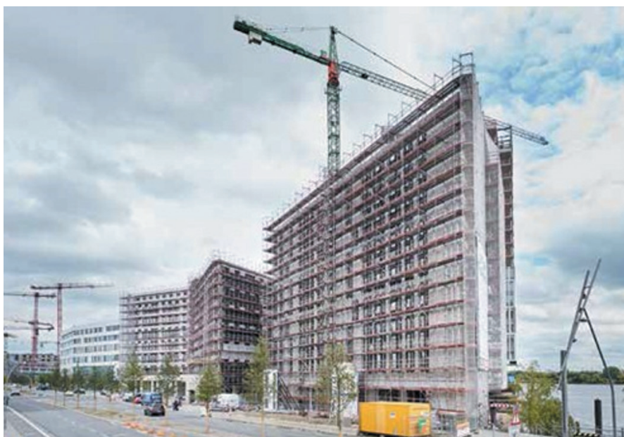
В 2017 году в Гамбурге на берегу Эльбы был построен ансамбль «Интеллектуальный квартал». При устройстве горизонтальных и вертикальных противопожарных барьеров компания Degen + Rogowski GmbH использовала систему «Fixrock BWM Brandriegel Kit» фирмы Rockwool.
