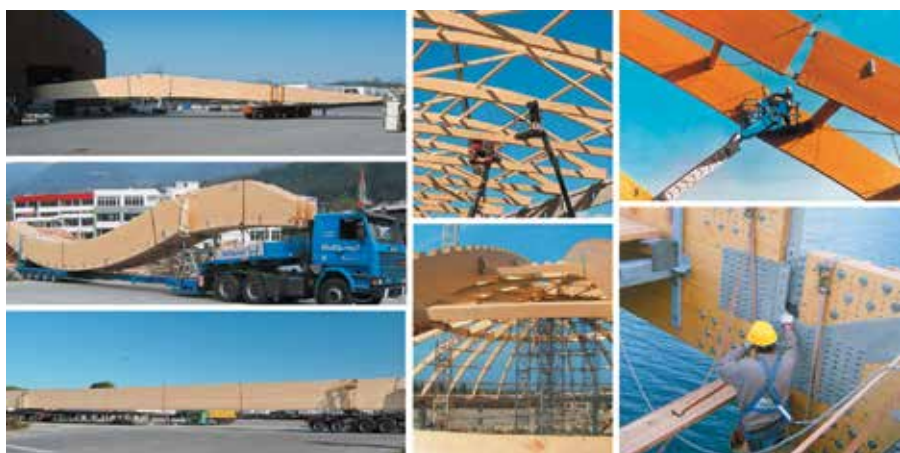
Транспортировка и монтаж деревянных клееных конструкций
