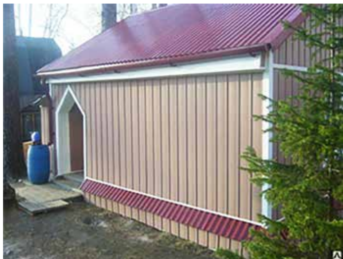
Рис. 3. Облицовка домов вертикальным (слева) и горизонтальным (справа) сайдингом из ПВХ
