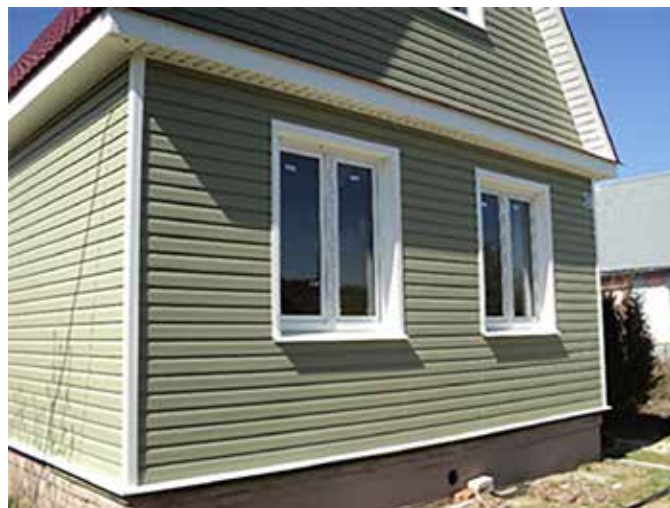
Рис. 3. Облицовка домов вертикальным (слева) и горизонтальным (справа) сайдингом из ПВХ
