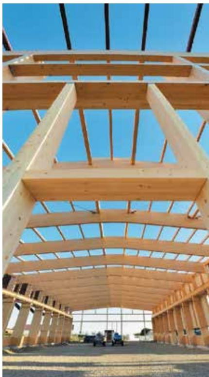
Различные стадии строительства BSH-конструкций
